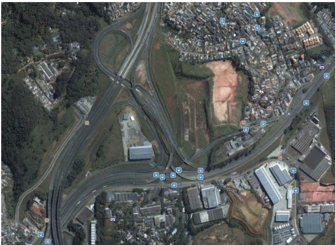
Figura 3.48: Cruzamento entre o Rodoanel Mário Covas e a Rodovia Régis Bittencourt na Grande São Paulo – exemplo de solução sofisticada em cruzamento.
