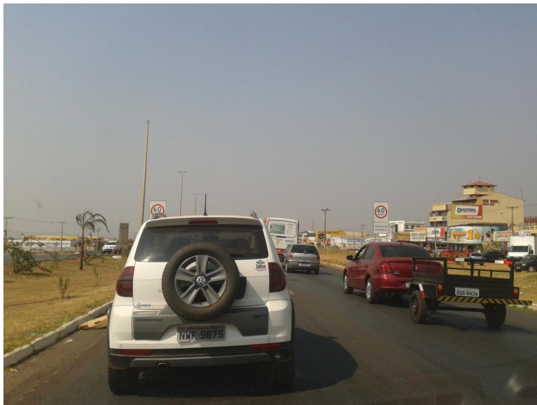
Figura 3.2: fotografia de trecho urbano da BR-040 em Valparaíso, GO.
