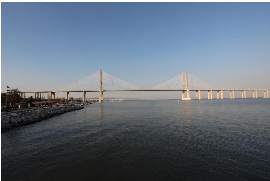
Figura 4.19: Ponte Vasco da Gama.
