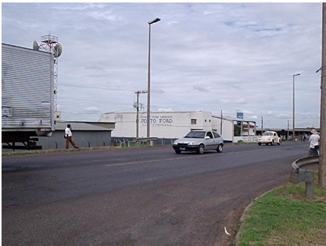
Figura 3.36: Fotografia da BR-050 – travessia urbana antes das intervenções.
