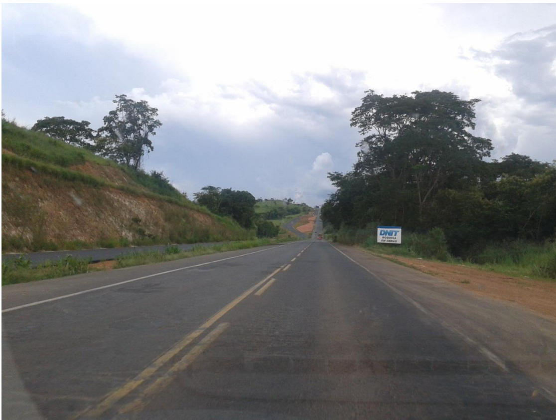
Figura 3.6: Fotografia das obras de duplicação da BR-050 em Araguari, MG.
