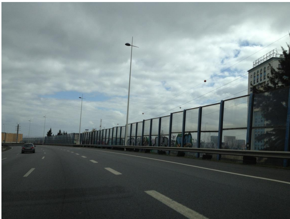
Figura 4.21: Proteção contra ruídos nos trechos urbanos de autoestrada em Lisboa.
