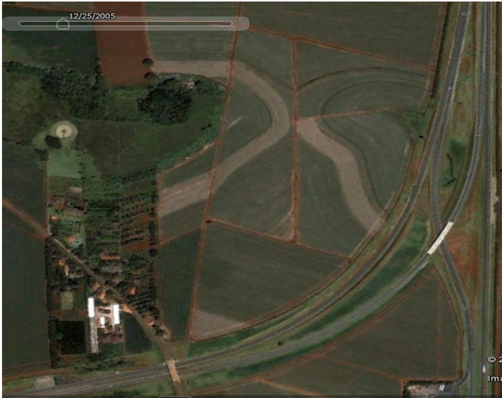
Figura 3.47: Exemplo de viaduto com faixas direcionais, no cruzamento entre as rodovias Anhanguera e Bandeirantes, nas proximidades de Cordeirópolis, SP.
