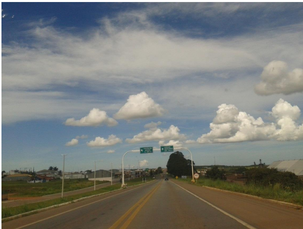
Figura 3.3: Fotografia de trecho urbano da BR-050 em Cristalina, GO.
