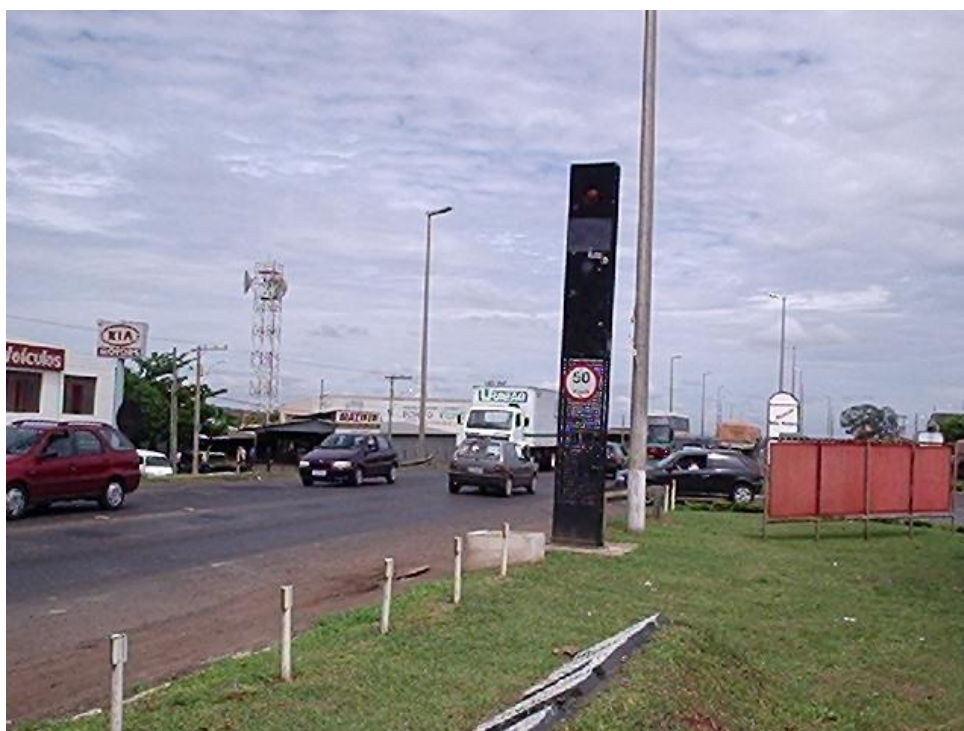
Figura 3.37: Fotografia da BR-050 – travessia urbana antes das intervenções.
