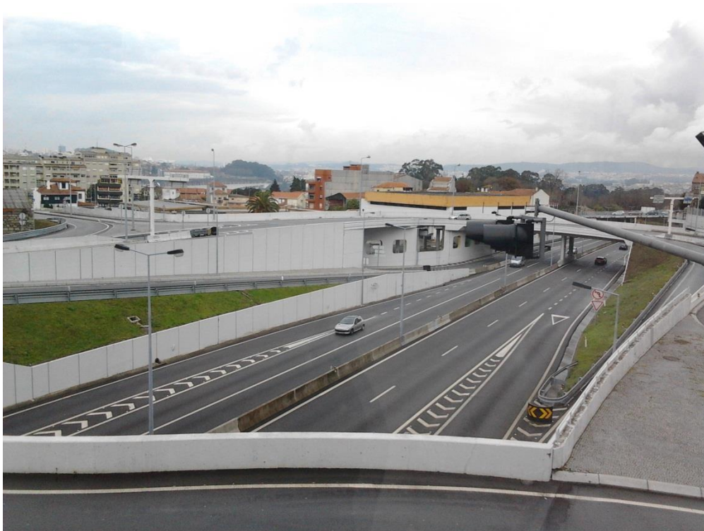
Figura 4.6: Travessia urbana em Vila Nova da Gaia.
