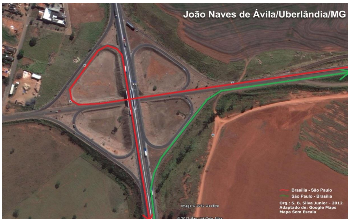
Figura 3.46: Acesso sul ao contorno e os “malabarismos” para se permanecer no eixo.
