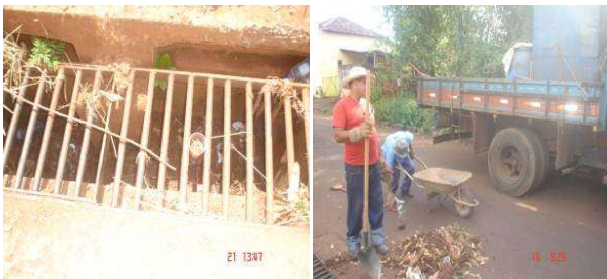
Figuras 44 e 45 - Manutenção dos bueiros (Setor Sul), setembro de 2009. Fotos: João Carlos de Oliveira.
