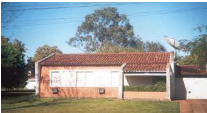
FIGURA 171: Residência original Tipo 3 - T 09 13 para funcionários de nível superior. FONTE: ALMEIDA, Daniel A. M. A., 2002.
