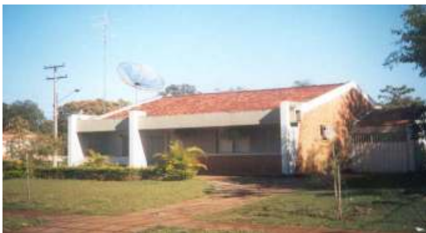
FIGURA 172: Residência original Tipo 4 - T 09 23 para funcionários de nível superior. FONTE: ALMEIDA, Daniel A. M. A., 2002.
