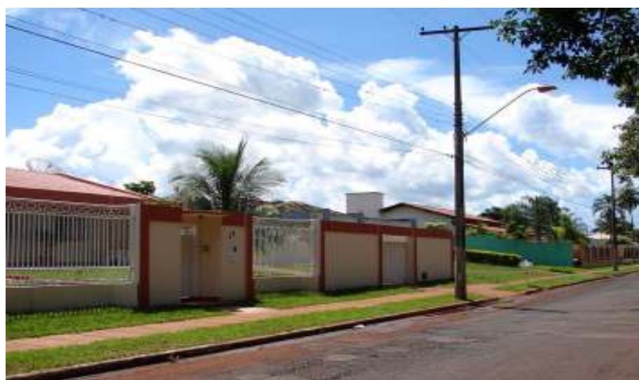
FIGURA 176: Vila de Furnas Itumbiara em 2008 – muros altos e gradis nas casas modificadas FONTE: MIGUEL, Laura F. S., 2008
