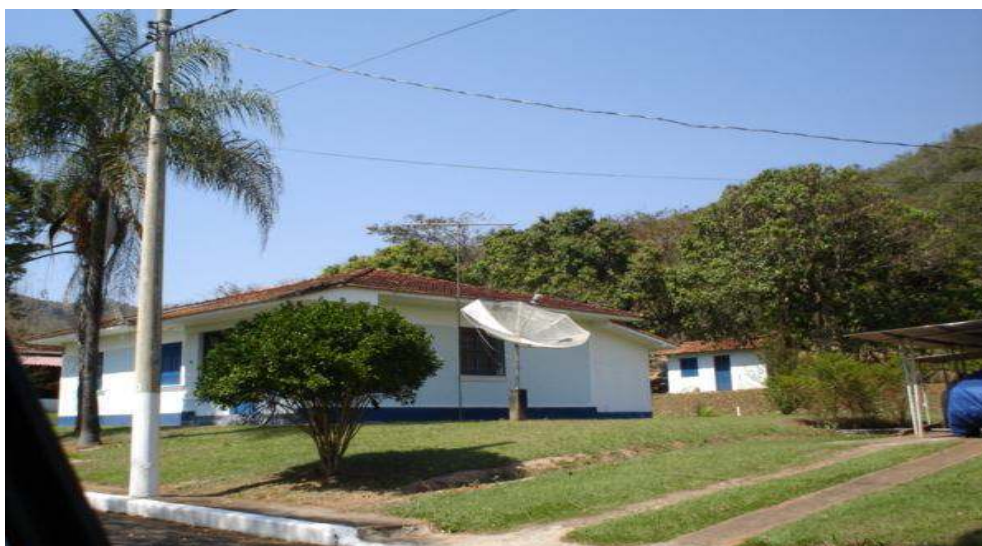
FIGURA 102: Setor residencial 1 - cobertura para automóvel na lateral e “quarto de despejos” no fundo da residência.
