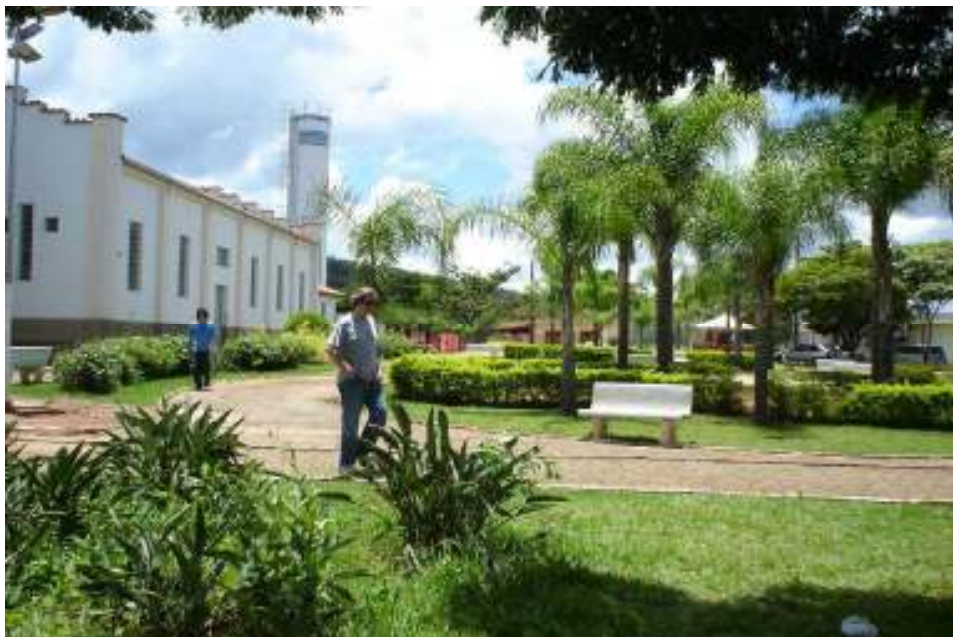
FIGURA 75: Igreja e praça São José, intervenção inadequada do reservatório no conjunto edificado FONTE: GUERRA, M. A. E. , 2008.
