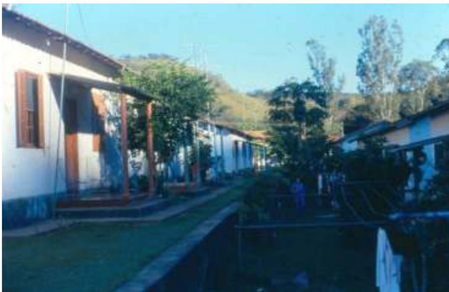
FIGURA 108: Setor 2 – residências geminadas, dispostas em platôs escalonados. FONTE: Slides digitalizados: GUERRA, M.E.A., Original: Furnas s/d.
