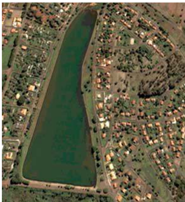
FIGURA 113: Vista aérea da vila operadora de Planura onde se percebe a predominância espacial do lago s/d FONTE: Disponível: < http://www.planura.mg.gov.br/ >. Acesso em: 8 fev.2008
