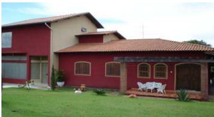
FIGURA 88: Setor 1: residência modificada, em dois pavimentos consultório médico. FONTE: GUERRA, M.E.A, 2008
