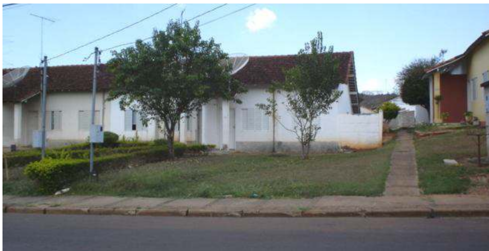
FIGURA 62: Setor 1 – Residências geminadas quatro a quatro, Rua Guapé, à direita via de pedestres FONTE: GUERRA, M.E.A, 2005
