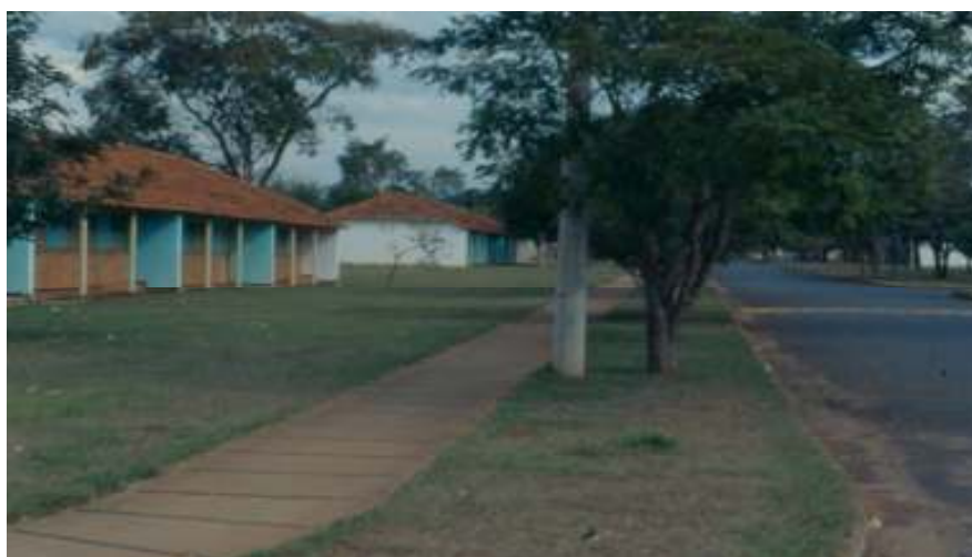
FIGURA 205: Vila de Fronteira – rua com pavimentação e passeio na década de 1980. FONTE: Slides digitalizados GUERRA, M.E.A,originais DEC.E Furnas Rio de Janeiro, s/d.
