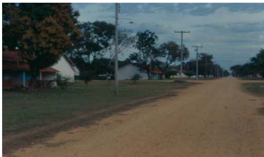
FIGURA 204: Vila de Fronteira – rua sem pavimentação no final da década de 1970. FONTE: Slides digitalizados GUERRA, M.E.A,originais DEC.E Furnas Rio de Janeiro, s/d.
