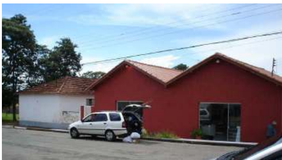
FIGURA 89: Setor comercial: supermercado em edificação reformada e ampliada. FONTE: GUERRA, M.E.A, 2008
