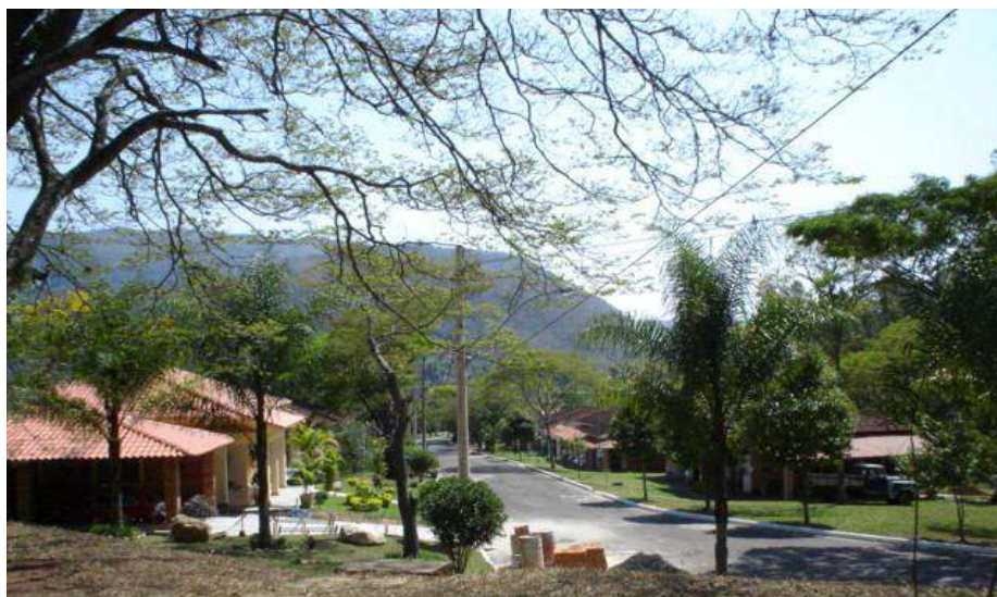
FIGURA 111: Aspectos físicos naturais e construídos – Setor residencial 1. FONTE: GUERRA, M.E.A., 2005
