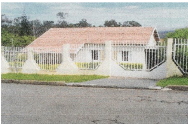
FIGURA 207: Residência da Vila de Estreito: Tipo TC reformada com a inclusão de gradil FONTE: LIPORONE, F. 2004.
