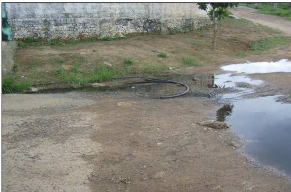
Figura 41 – Caldas Novas: transbordamento de fossas no bairro Itanhangá I. Nesse caso o proprietário instalou uma mangueira, para que esse esgoto seja conduzido para um ponto distante da residência.
