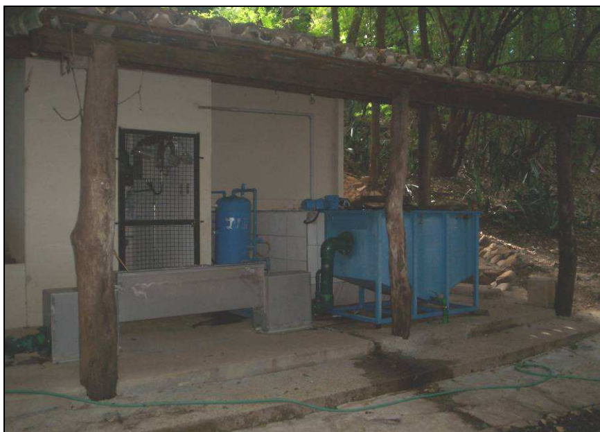
Figura 48 – Caldas Novas: Um dos empreendimentos hoteleiros nas margens do Córrego de Caldas promove, por meio de um reator aeróbio, o tratamento do esgoto produzido.
