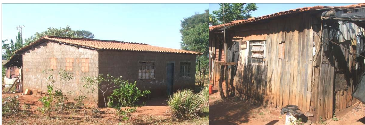
Figura 81 – Uberlândia (MG): à esquerda, casa de alvenaria sem reboco (Lote 13); à direita, casa feita de madeira (Lote 8)
