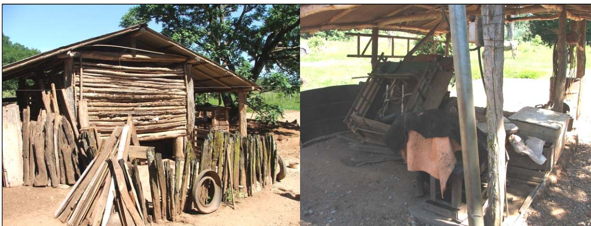
Figura 43 – Uberlândia (MG): vista parcial do galpão de ferramentas e abrigo para carroça. Observar-se a madeira em pé para evitar a presença de animais e insetos
