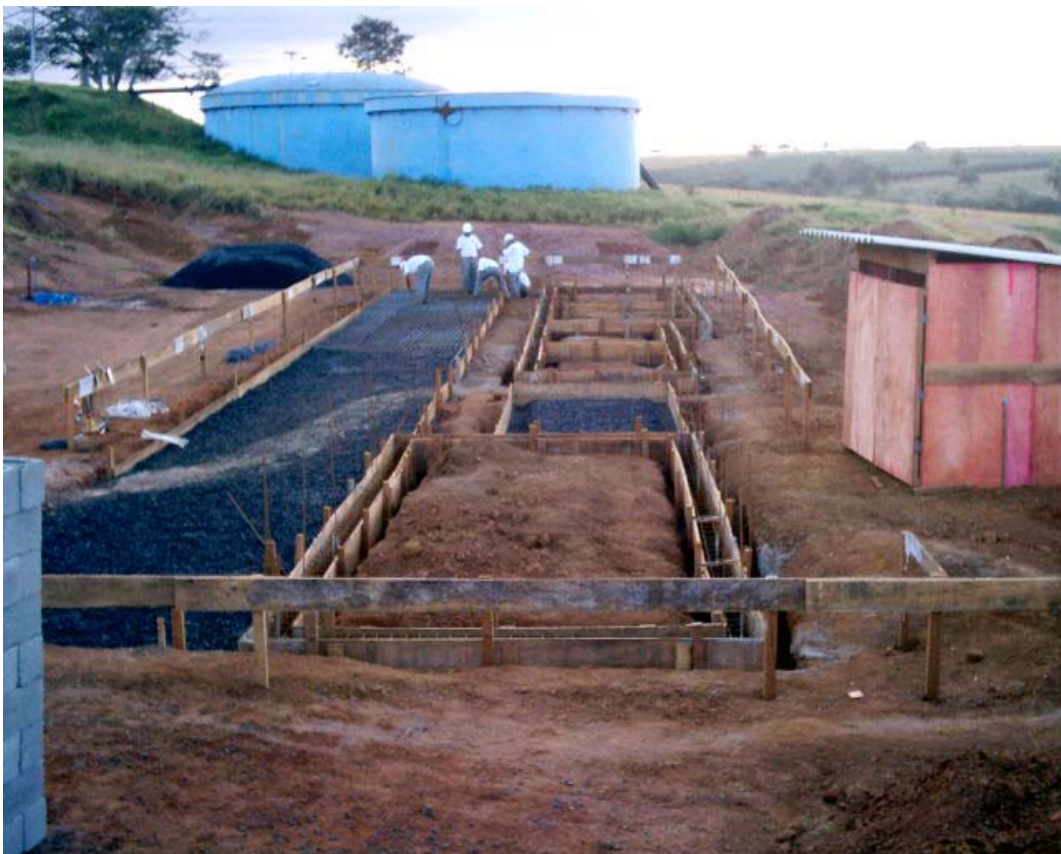
Figura 3.5 - Fundação do canal de trat. e módulo de equip. – 22/06/2005. Fonte: Autor.
