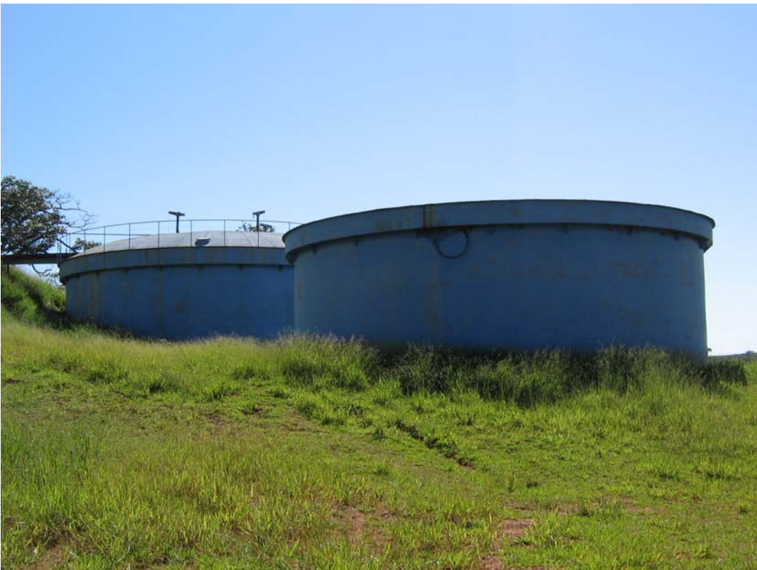
Figura 3.2 – Reator anaeróbio e filtro biológico. Fonte: Autor.
