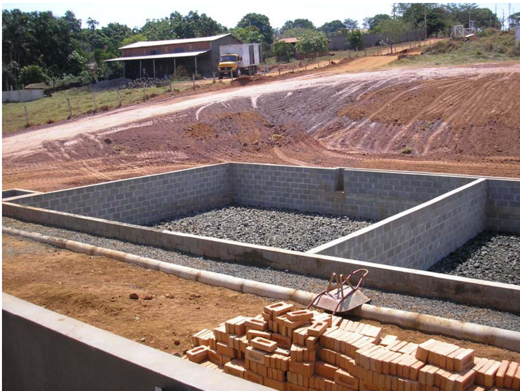
Figura 3.8 - Término da construção do leito de secagem de lodo – 17/10/2005.
