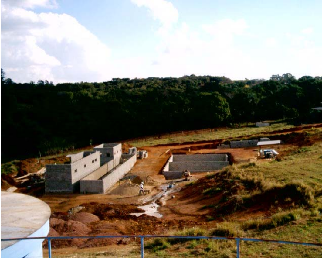
Figura 3.6 - Vista geral da construção – 22/07/2005. Fonte: Autor.
