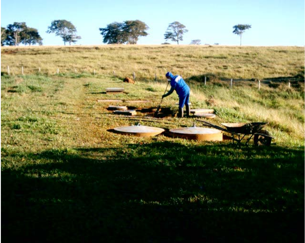
Figura 3.1- Desarenador e gradeamento. Fonte: Autor.
