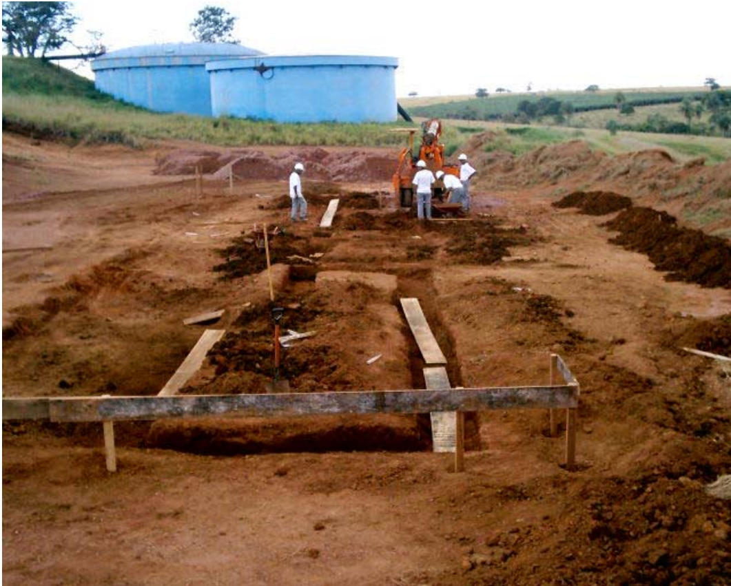
Figura 3.4 - Início das obras – 31/05/2005. Fonte: Autor.
