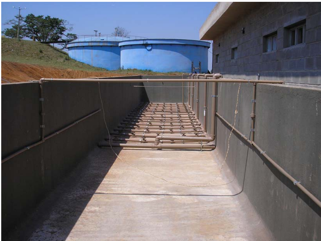
Figura 3.7 - Término da construção do canal de tratamento e módulo de equipamentos – 17/10/2005. Fonte: Autor.
