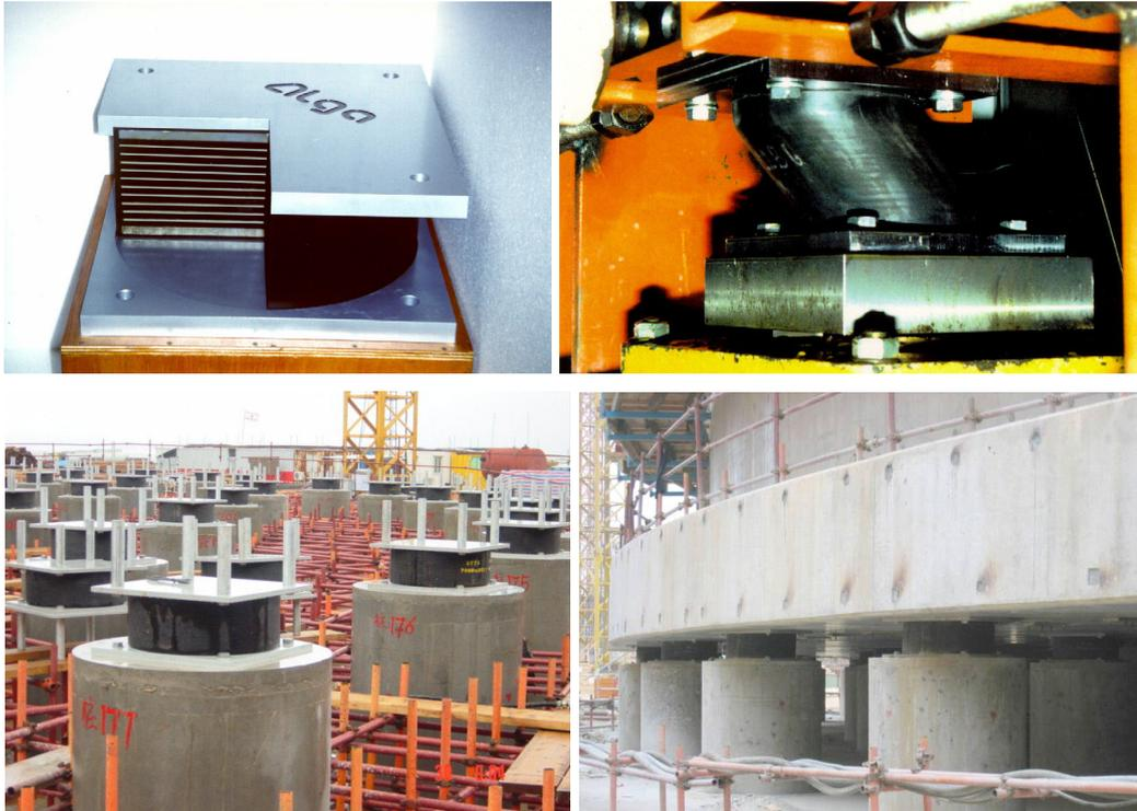
Figura 1.8 - Aplicação de amortecedores viscoelásticos para isolamento de estruturas civis (MARIONI, 1998; DUSI et al., 2007).
