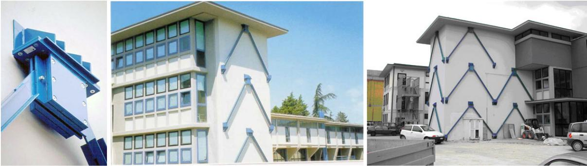
Figura 1.4 - Amortecedores viscoelásticos aplicados na área de construção civil (CLEMENTE et al., 2004).
