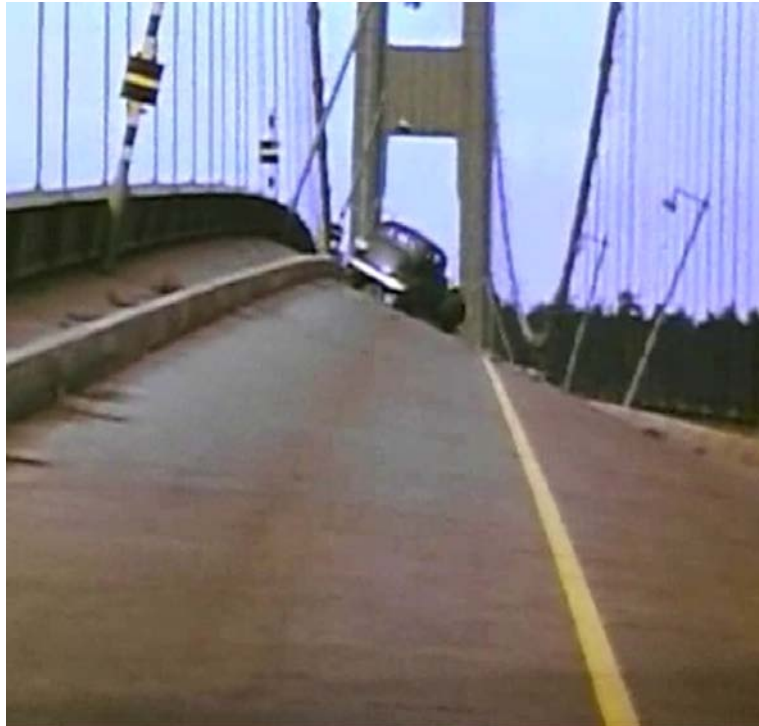
Figura 2.6 – Famoso caso da ponte Tacoma Narrows , onde o efeito de ventos constantes provocou a sua destruição em 1940.
