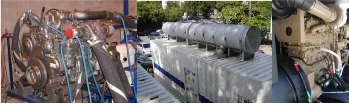
Figura 2.13 – Motor (esquerda) e geradores Diesel convertidos para o consumo do gás (1.2MW e 360kW, centro e direita respectivamente) (PEREIRA et al., 2005)
