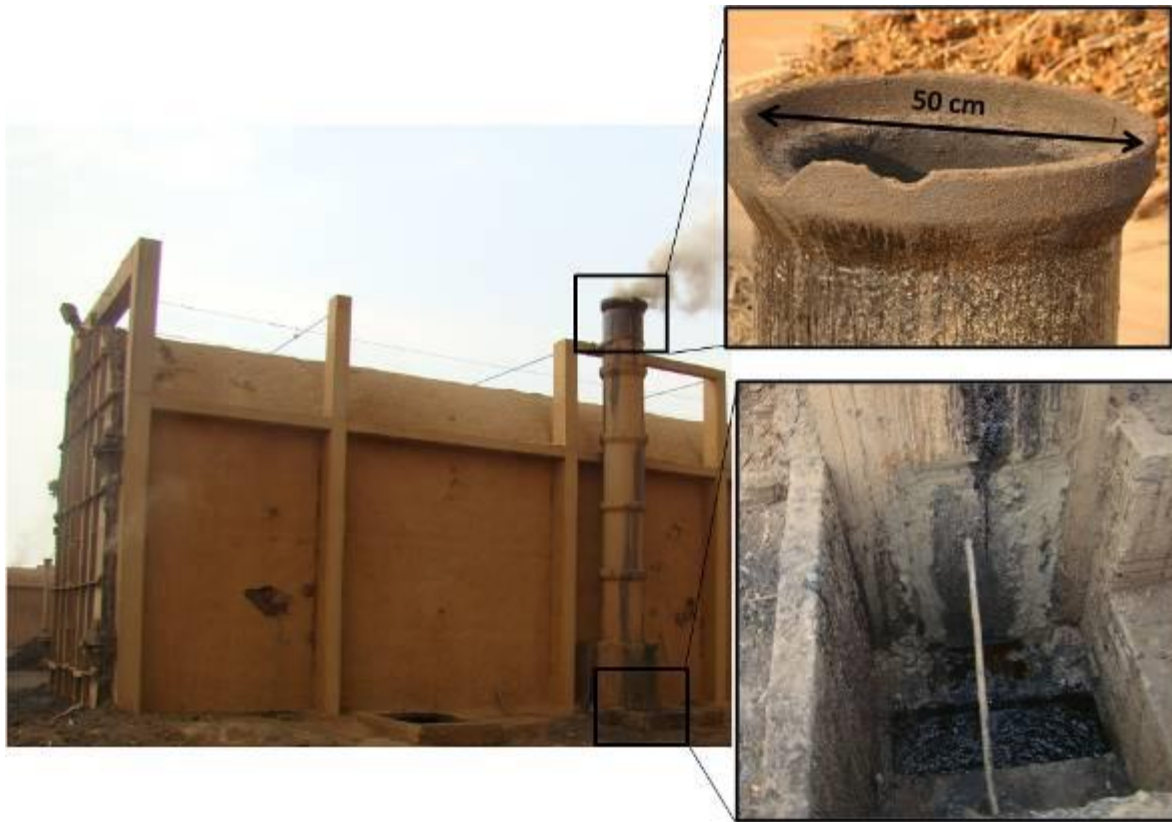
Figura 3.3 – Representação do canal de fumaça e chaminé (baixo para cima respectivamente)
