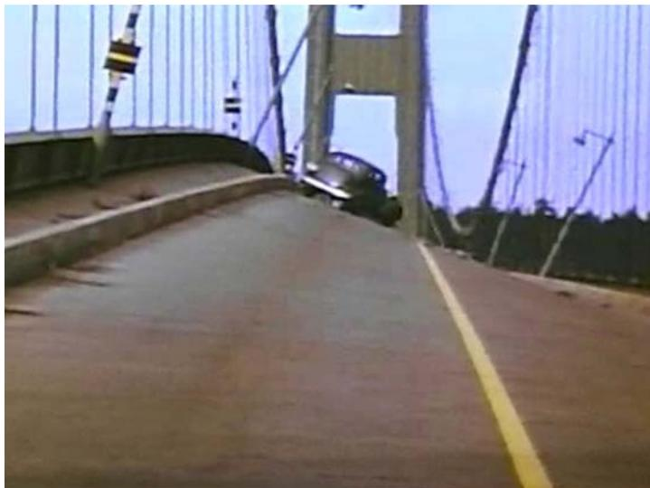
Figura 2.1 – Ponte Tacoma Narrows, efeito de ventos provocaram a sua destruição em 1940. (fonte: [www.lmc.ep.usp.br](http://www.lmc.ep.usp.br) ).
