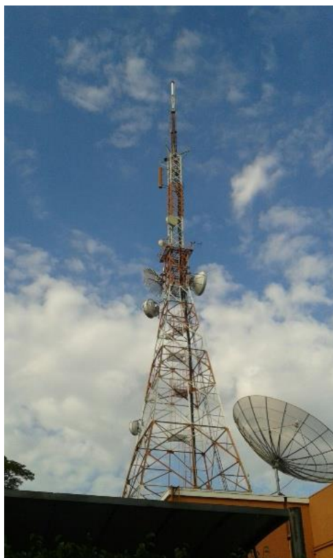
Figura 35: Torre da emissora C
