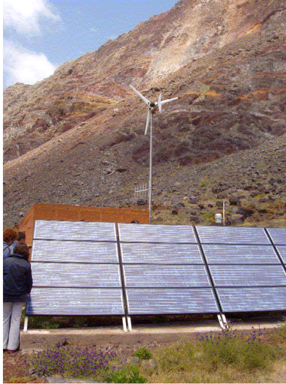
Figura 2.11 – Sistema híbrido (eólico e solar) existente em uma comunidade isolada da Ilha da Madeira, Portugal [22].
