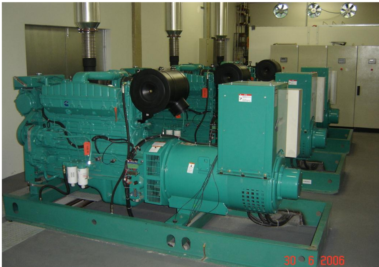
Figura 1.3 – Usina Geradora de 2MVA projetada e instalada pelo autor na indústria Sherwin Willians em Taboao de Serra SP Brasil
