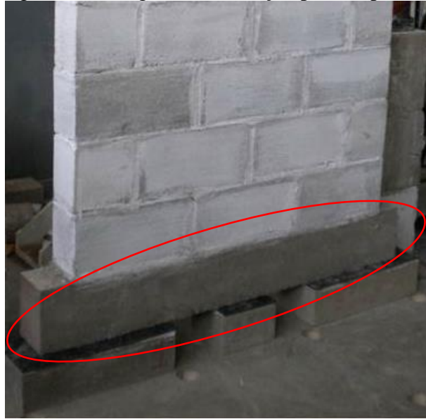
Figura 4.8 – Viga de sustentação para os painéis
