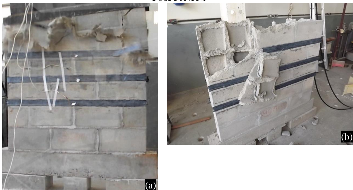
Figura 7.4 – Grupo G3-A: (a) ruptura do painel P05F50N3NJ; (b) ruptura do painel P06F50N3NJ
