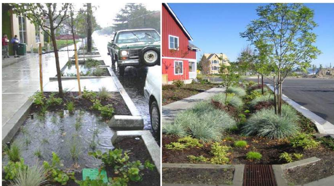
FIGURA 81 (a) e (b)– Exemplos de “jardins de chuva”, no Mercado New Seasons e no High Point Redevelopment em Seattle - Estados Unidos, ambas são intervenções propostas do projeto denominado Open Space Seattle .
