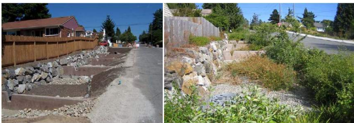
FIGURA 83 (a) e (b) – Sistema de contenção, nas bordas e fundo dos “jardins de chuva”, em vias no norte de Seattle , Estados Unidos.
