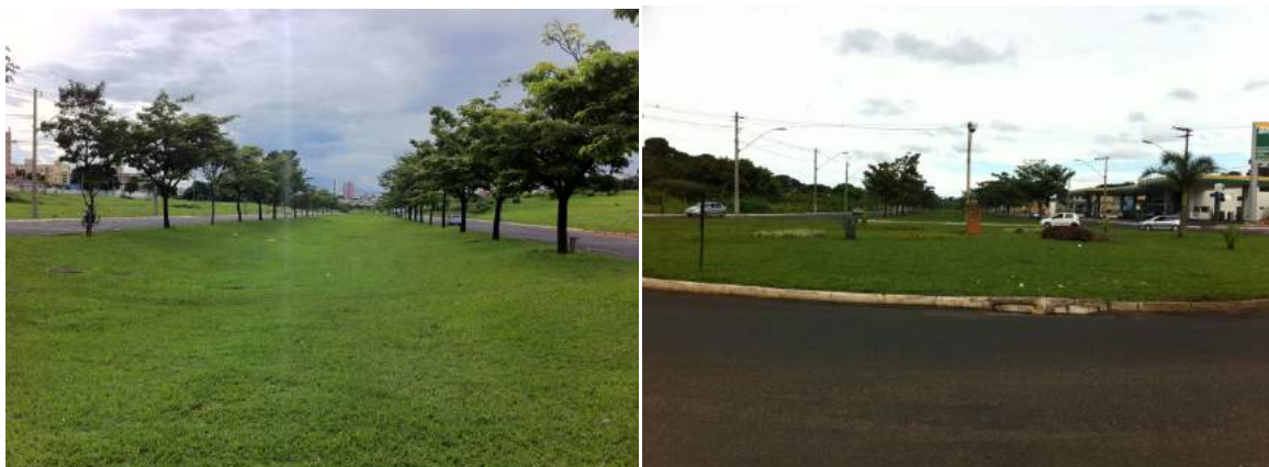
FIGURA 53 (a) e (b) – Avenida Anselmo Duarte, em 2010. FONTE: SEM AUTOR. Disponível em: < http://maps.google.com.br >. Acesso em outubro 2010.
