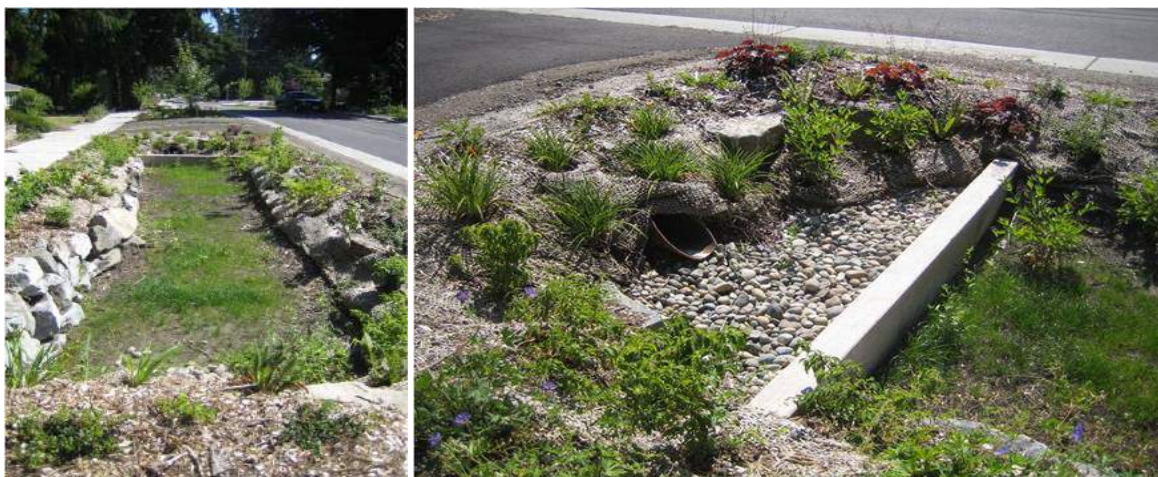
FIGURA 84 (a) e (b)– Área específica para sedimentação e limpeza de resíduos, em vias de Pinehurst , em Seattle , Estados Unidos.
