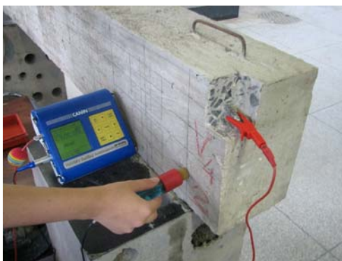
Figura 3.23 – Ensaio de Potencial de Corrosão na Viga V4
