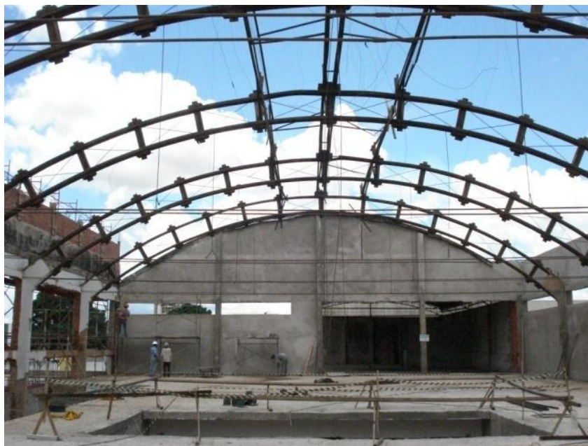
Figura 81 – Galpão em reforma em 2010
