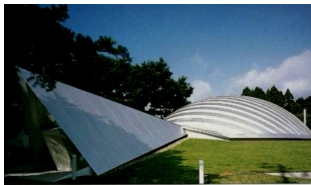
d) Revestimento policarbonato e aço
