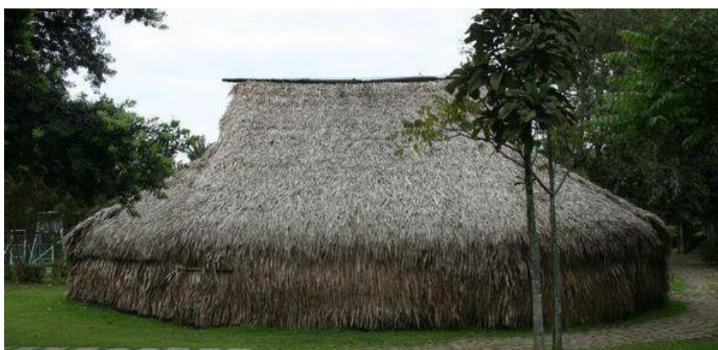
Figura 12 – Sistema construtivo de malocas no Brasil Fonte: Butler (2006)
