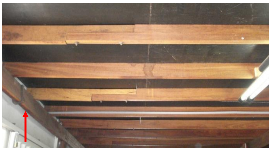
Figura 131 – Mezanino construído em madeira
