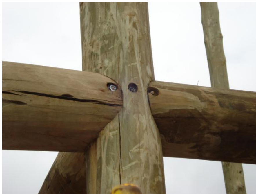
Figura 100 – Ligações parafusadas e encaixadas
