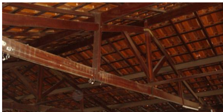
Figura 25 – Treliça de madeira em restaurante na cidade de Uberlândia-MG
