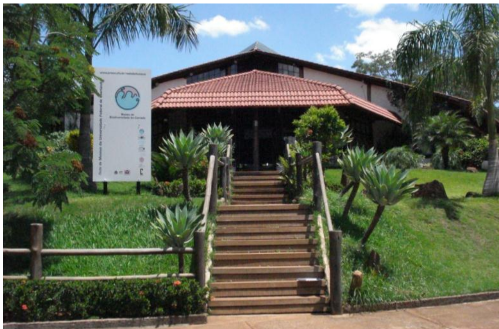
Figura 89 – Fachada Museu da Biodiversidade
