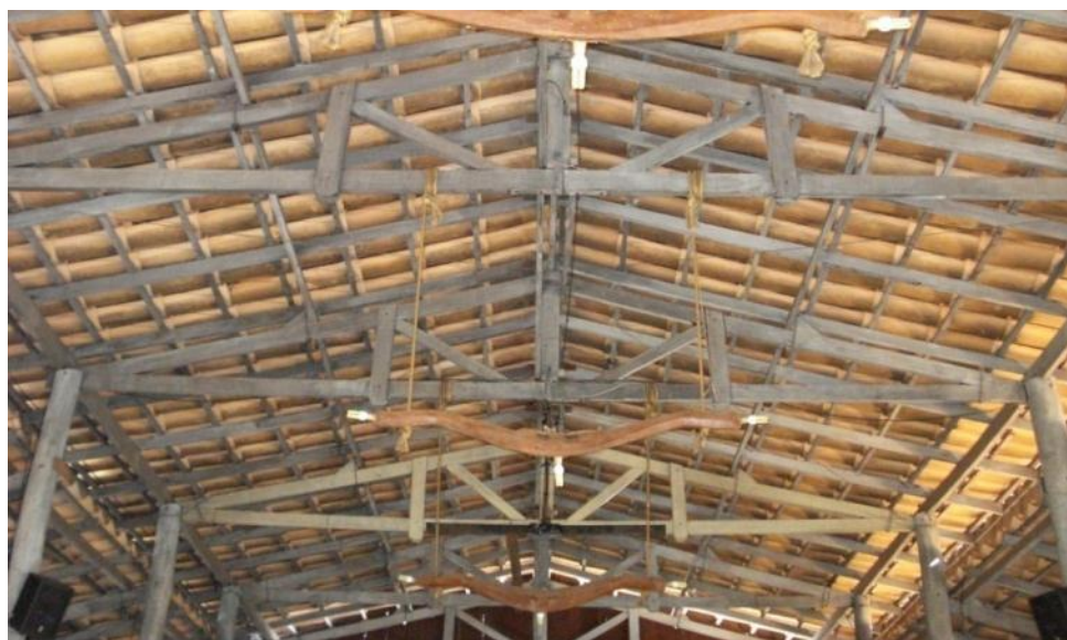
Figura 37 – Vista da treliça central
