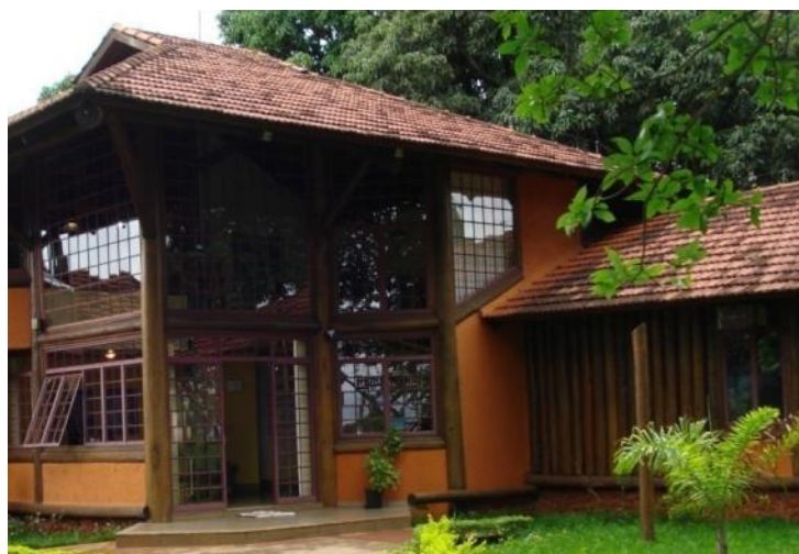
Figura 111 – Detalhes dos pilares externos
