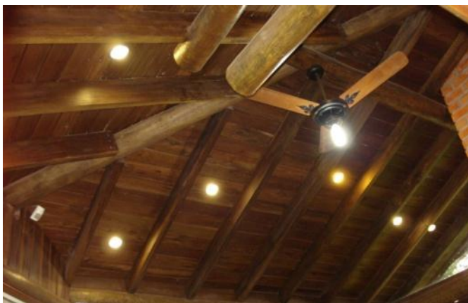
a) Vigas e forro em eucalipto serrado
