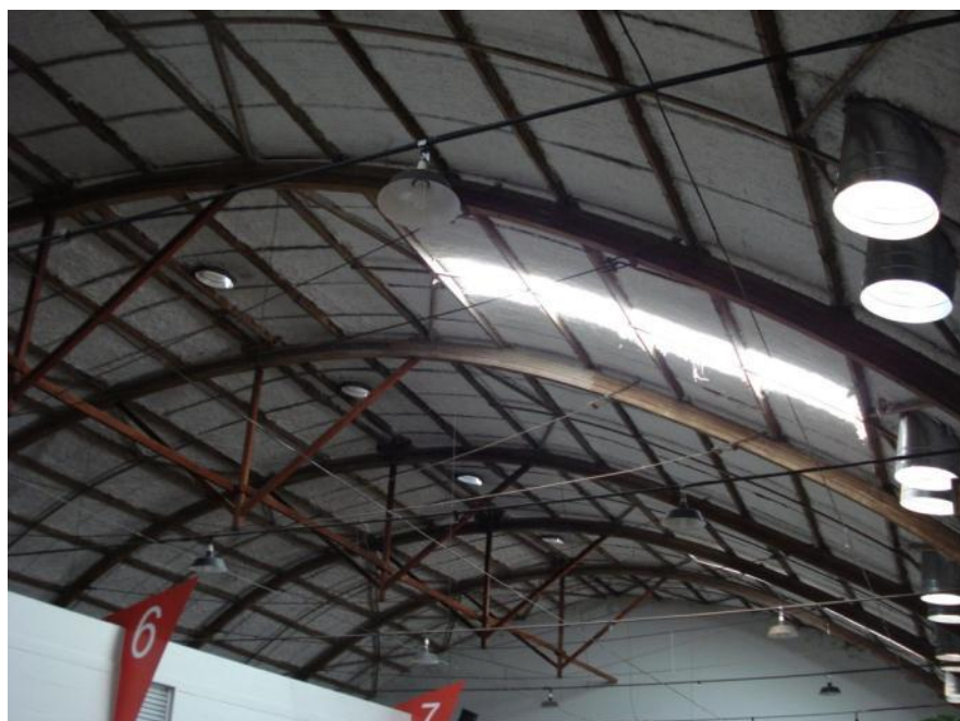
Figura 96 – Arcos em madeira laminada colada atirantados em aço
