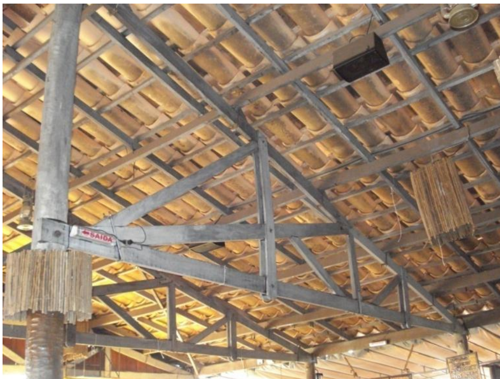
Figura 38 – Vista da treliça lateral
