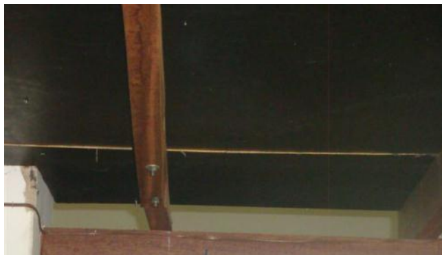
b) Emenda em flexão – desalinhada
