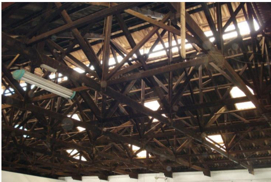
Figura 84 – Estrutura da cobertura do galpão para oficina mecânica
