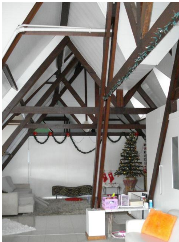
Figura 103 – Vista das estruturas aparentes
