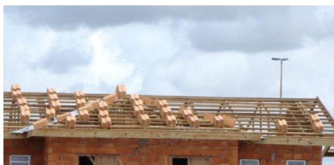
b) Estrutura já aplicada
