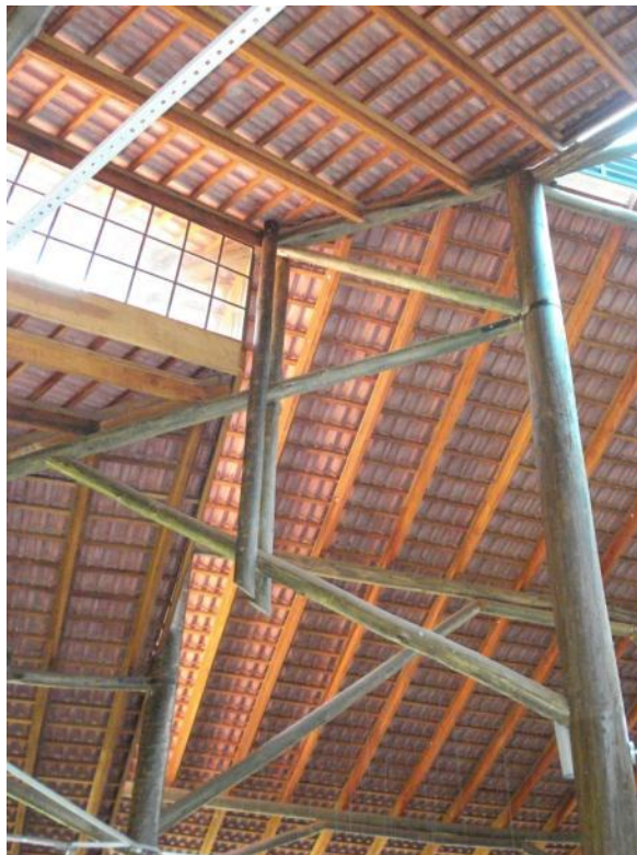
Figura 92 – Detalhe de parte da estrutura do pórtico
