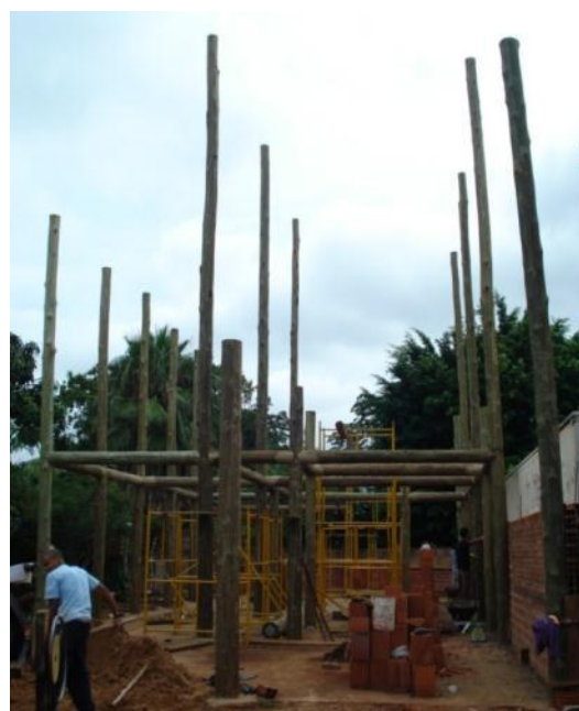
b) Montagem da estrutura
