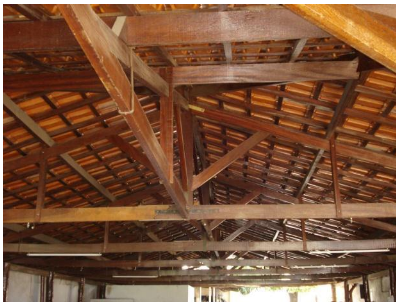
Figura 72 – Estrutura principal do estacionamento
