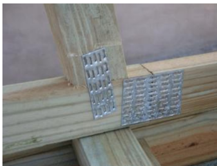
c) Ligações por chapas metálicas dentadas
