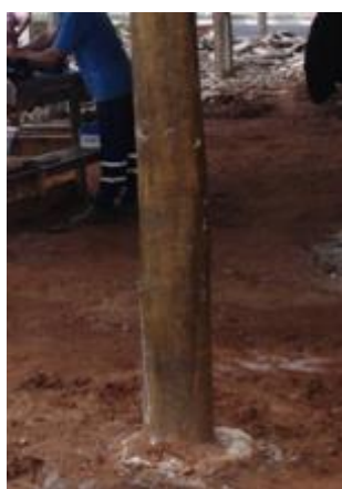
a) Fixação do pilar no solo
