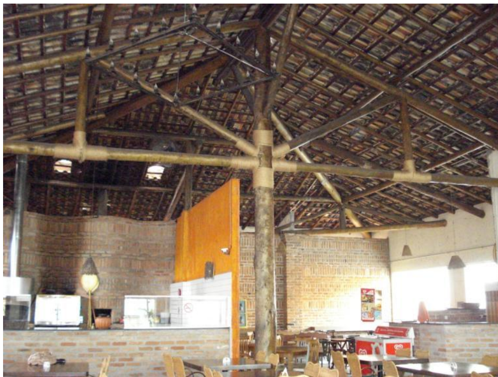
Figura 51 – Estrutura principal da construção
