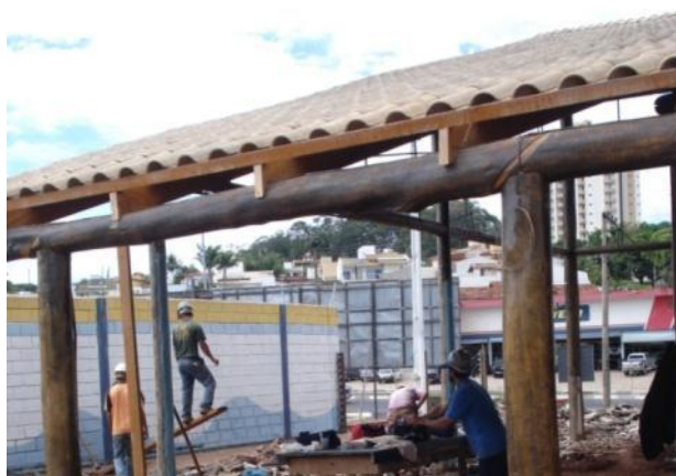
b) Vigas circulares e fixação das vigas serradas que recebem a cobertura
