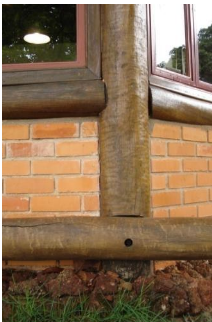
Figura 113 – Pilar apoiado em concreto e viga parafusada
