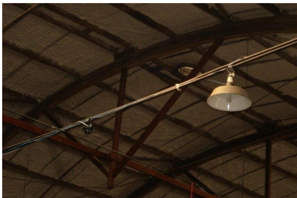
Figura 98 – Montante central: ligação de tirantes
