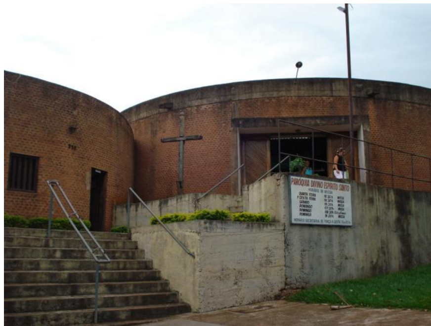
Figura 86 – Fachada original da igreja Imagem: BARDI (1999).
