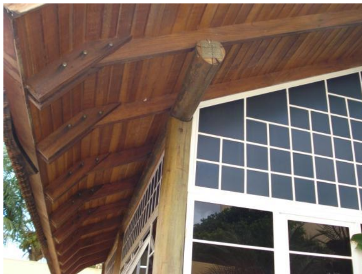
Figura 117 – Fixação das peças de beirais
