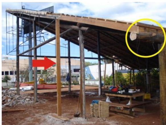
a) Elemento provisório de sustentação da viga de beiral
