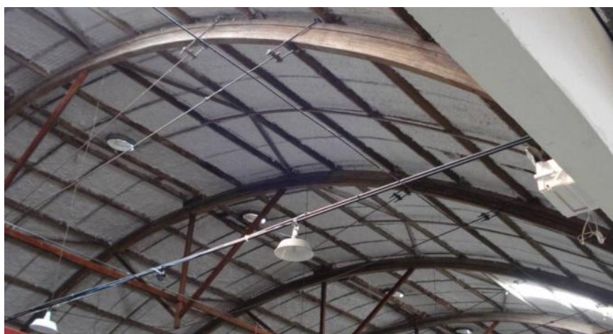
Figura 18 – Estrutura em arco em edificação na cidade de Uberlândia – MG
