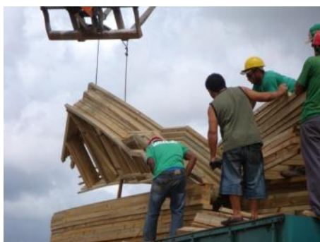
a) Descarga das estruturas pré-montadas
