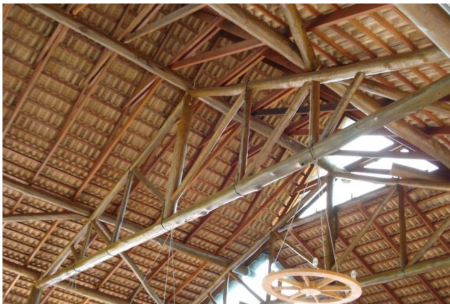
Figura 108 – Vista interna da estrutura principal
