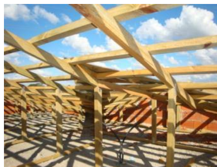
d) Vista inferior das estruturas já montadas
