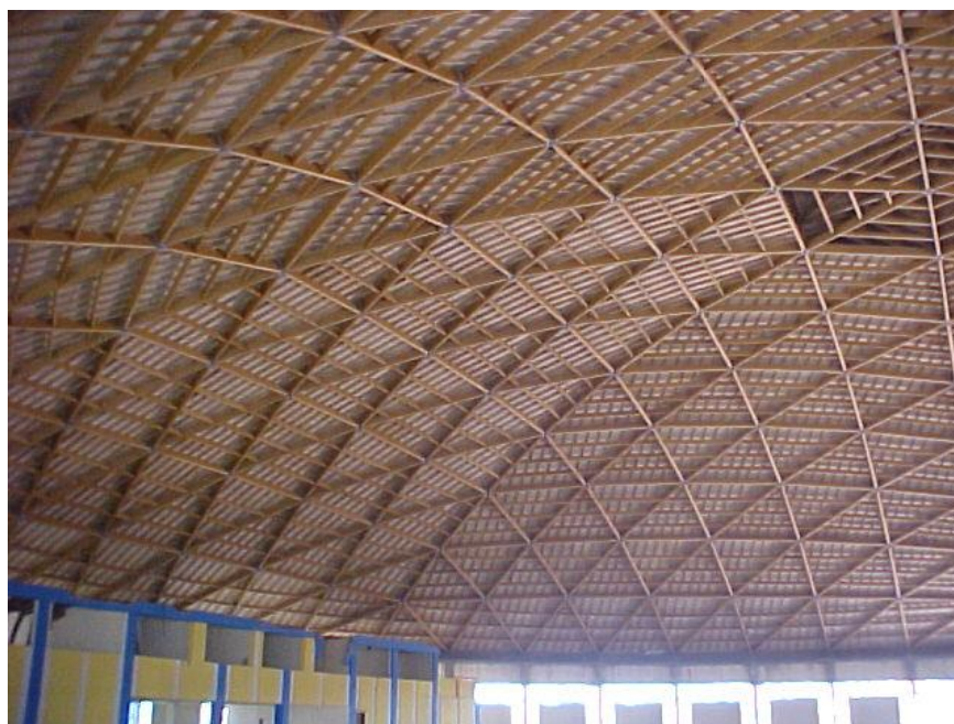
Figura 21 – Cúpula com 78,56 m de diâmetro feita com vigas de MLC de Pinus – Lages, SC
