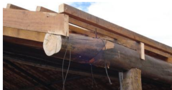
b) Detalhe de emenda em beiral
