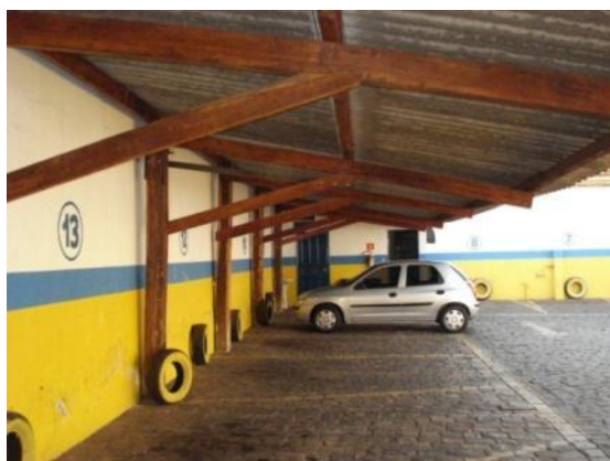
a) Estrutura em balanço
