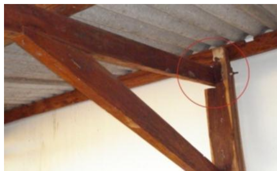
b) Ligação entre banzo e pilar
