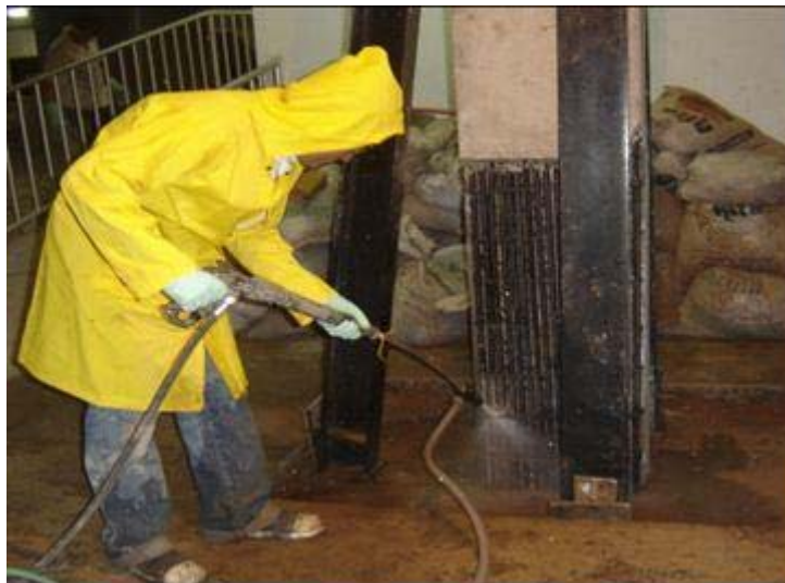
Figura 2.4 – Limpeza de armaduras.
