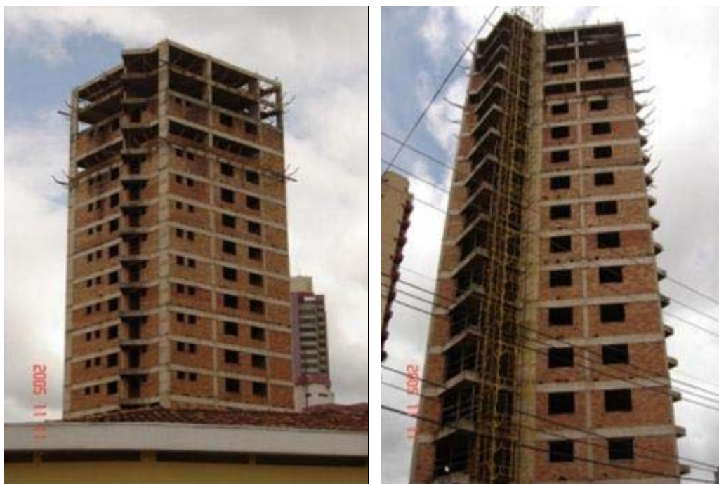
Figura 6.1 – Aspectos do edifício “A”.
