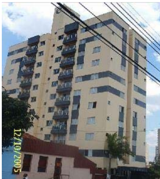
Figura 6.2 – Aspecto do edifício “B”.
