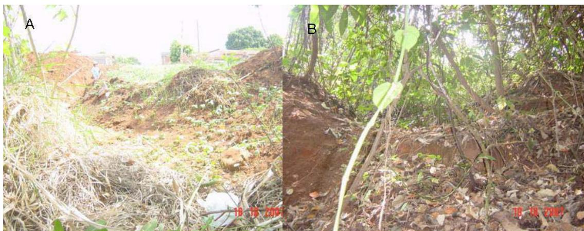
Figura 5.32: A- Visão à distância da canaleta; B- Voçoroca sendo formada pela força das águas da canaleta.
