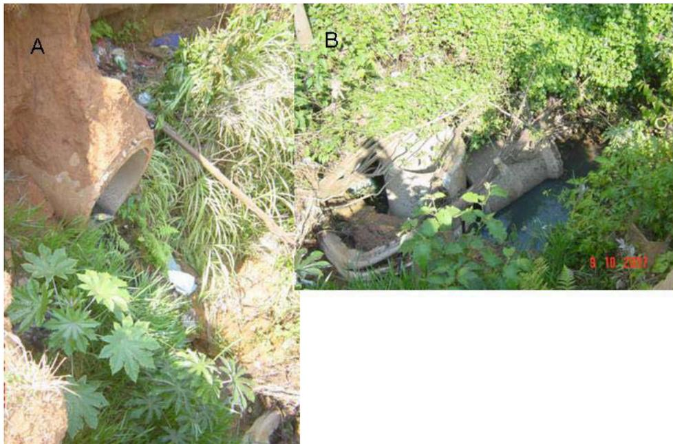
Figura 5.34: A- Final da rede de drenagem, B- Manilhas soltas dentro da voçoroca e água pluvial parada
