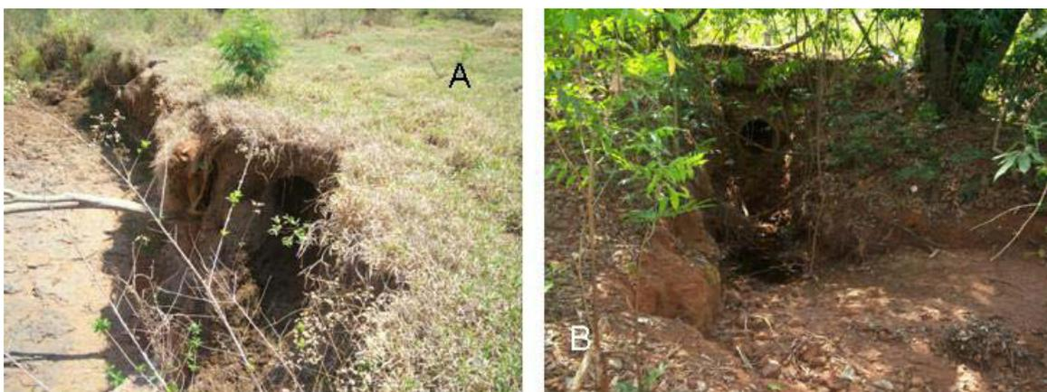
Figura 5.51: A- Voçoroca encontrada na área de estudo; B- Final de galeria de água pluvial e erosão em seu entorno.
