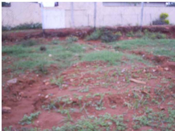
Figura 5.26: Erosão laminar devido às águas pluviais que não são inteiramente captadas pelo sistema de drenagem de águas pluviais.
