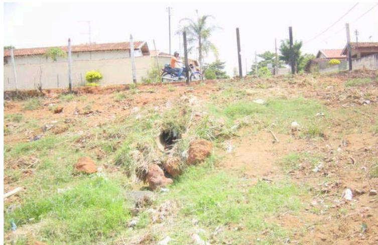
Figura 5.27: Final da rede de drenagem e concentração das águas pluviais lançadas diretamente sobre o terreno.
