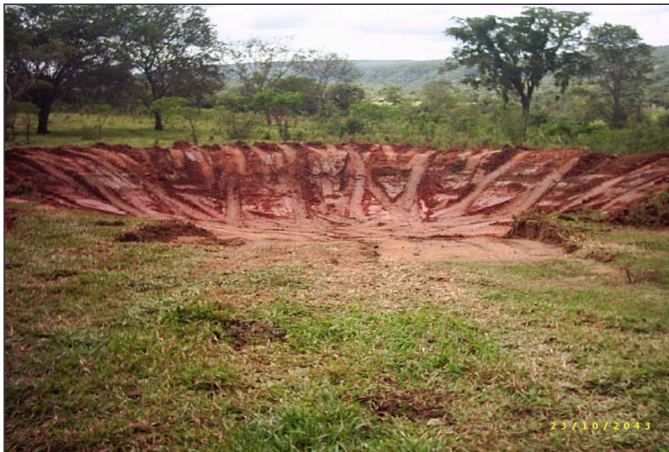
Figura 4.7 – Barraginhas, bacia de captação e retenção de água de chuva Fonte: Prefeitura Municipal de Montes Claros.
