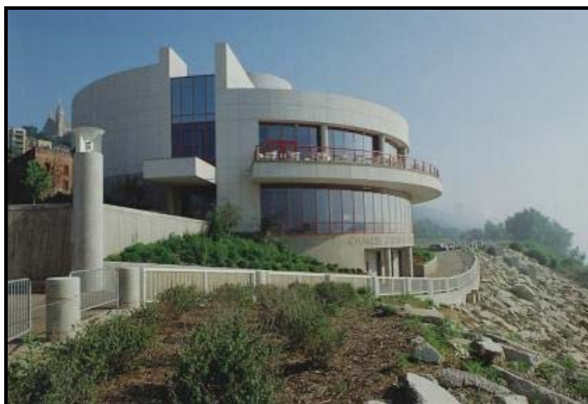
Figura 1.1 – Aplicação de painel de concreto – Boathouse em Sawyer Point, Cincinnati, Ohio.
