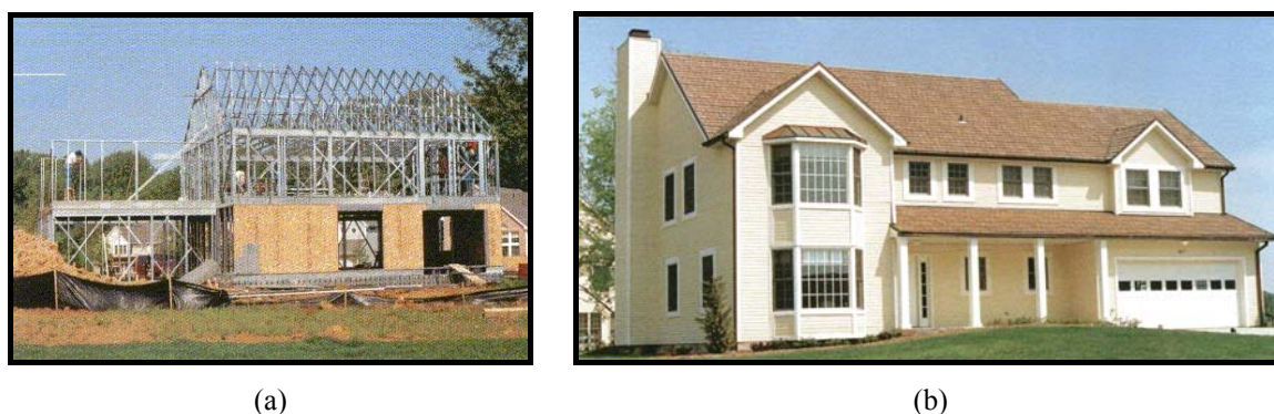
Figura 2.4 – Casa de conservação de Recursos em Maryland, Estados Unidos: (a) fase de montagem; (b) obra concluída.
