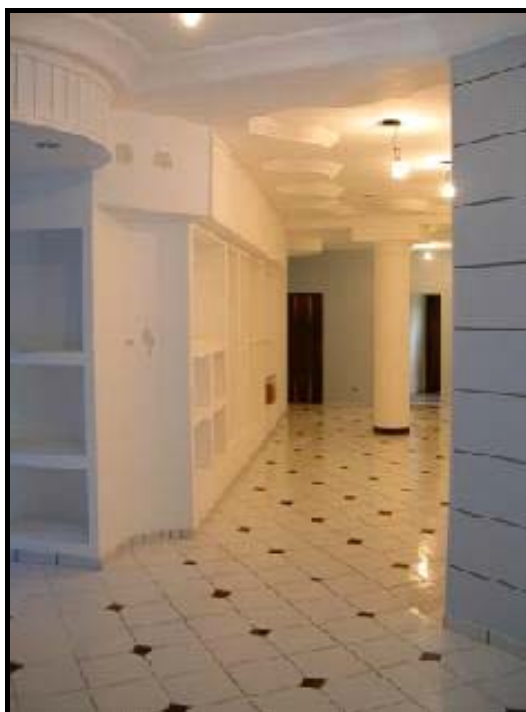
Figura 1.3 – Aplicação de painel de gesso acartonado.
