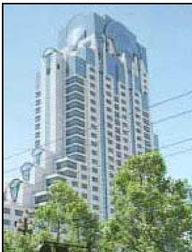
Figura 1.2 – Aplicação de painel GRC – San Francisco Marriott Hotel, Califórnia, EUA.
