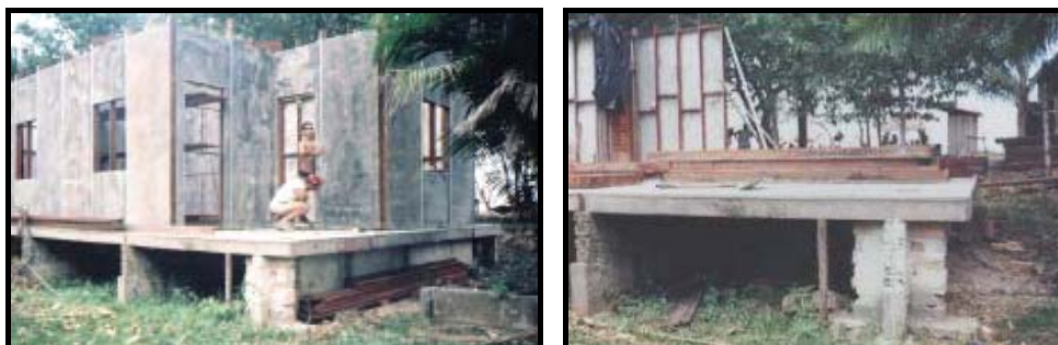
Figura 2.24 – Painéis sendo erguidos sobre a fundação.
