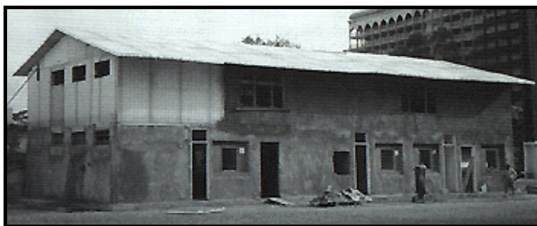
Figura 2.20 – Edificação em dois pavimentos com uso de painéis HI-TECH.
