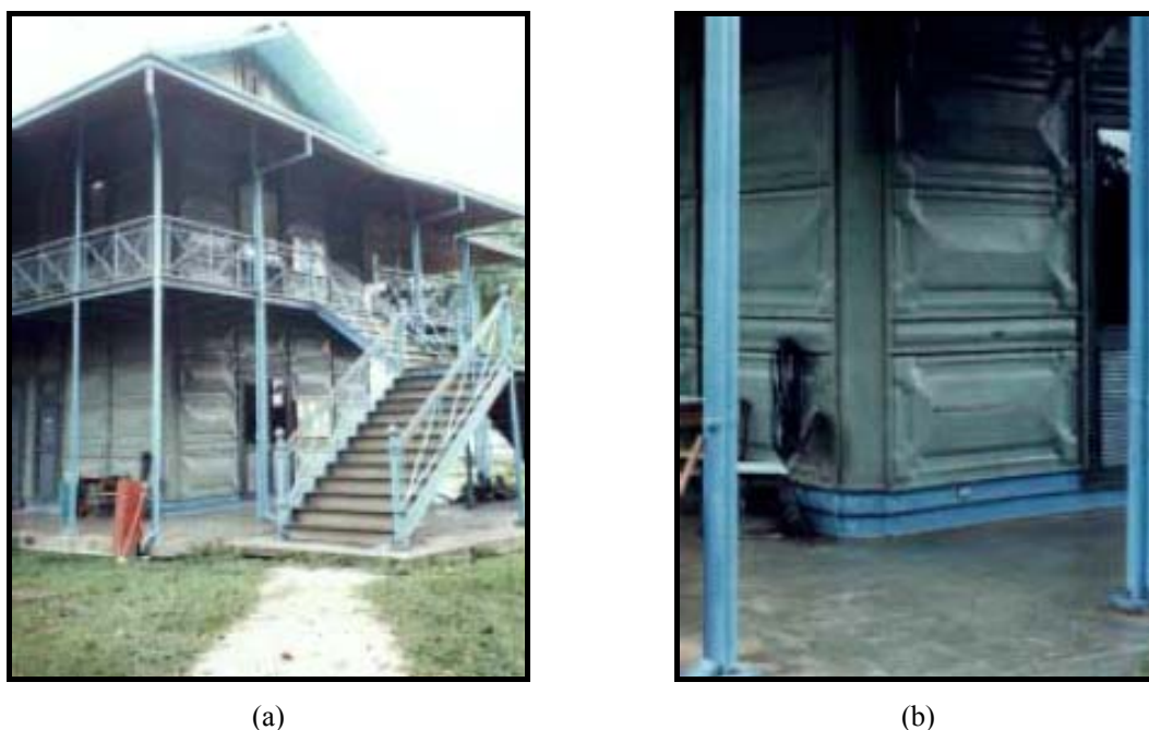
Figura 2.2 – Chalé no Campus da UFPA: (a) vista da fachada frontal; (b) detalhe do painel em chapa metálica.
