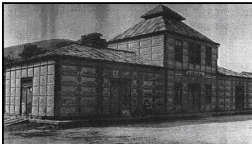
Figura 2.1 – Estação Ferroviária Bananal, São Paulo.
