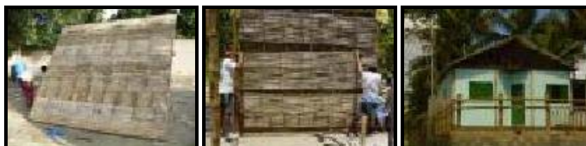
Figura 2.27 – Confecção de painéis de bambu e casa modelo.
