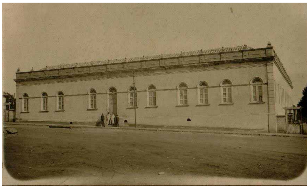
FIGURA 1 – MANOEL ALVES FEIJÓ. Fachada do Grupo Escolar Delfim Moreira – Araxá, MG. Entre 1920 e 1930. Fotografia. Araxá, Acervo SAPP/FCCB, n. 0169.
