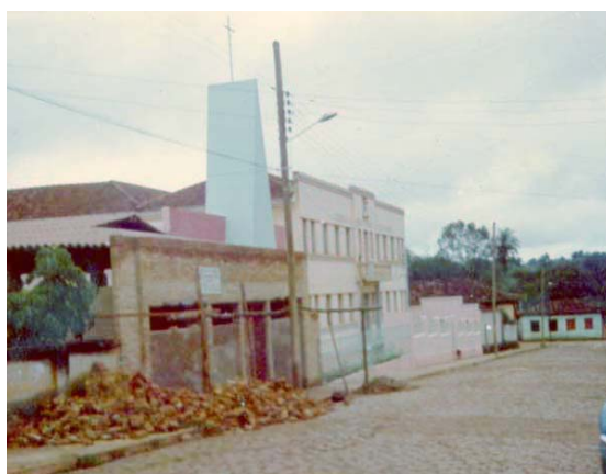
Figura 30: Reforma do prédio para construção do auditório, 1963.
