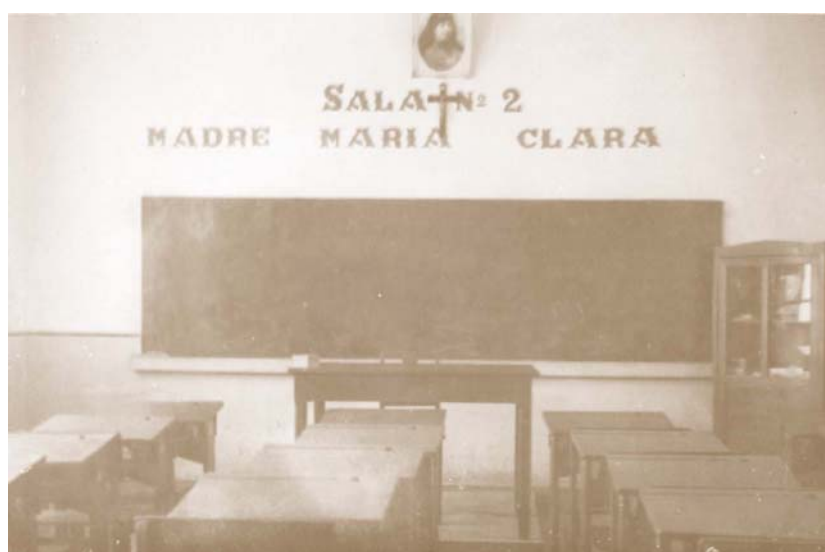
Figura 21: Sala de aula, anos de 1950, do Colégio Nossa Senhora do Amparo.
