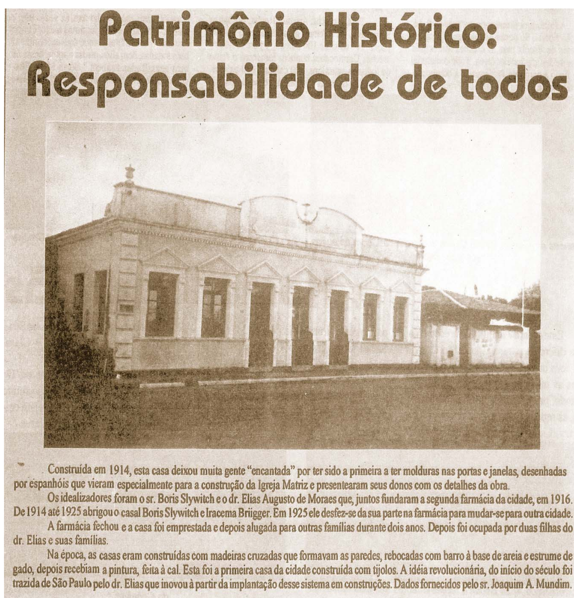
Figura 5: Casarão construído em 1914, sendo a primeira casa a ter molduras nas portas e janelas, desenhadas por espanhóis. (Sem data).
