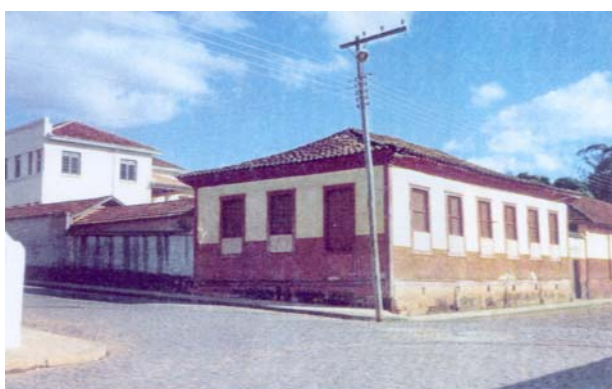
Figura 33: Vista lateral do Colégio Nossa Senhora do Amparo, esquina das ruas Padre Manoel Luiz com D. Sindá. Início de demolição 1978.
