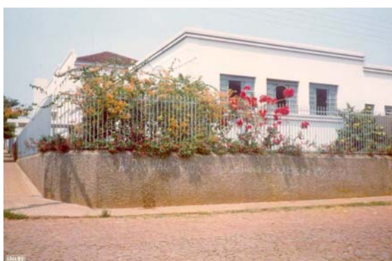
Figura 34: Novas salas de aula construídas após demolição da primeira casa a abrigar a escola, na rua D. Sindá, inauguradas em 1983.
