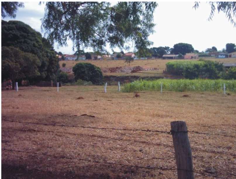
FIGURA 3 – Médio curso do córrego Buritizinho. Detalhe para a deposição de restos de construção civil para contenção da erosão.
