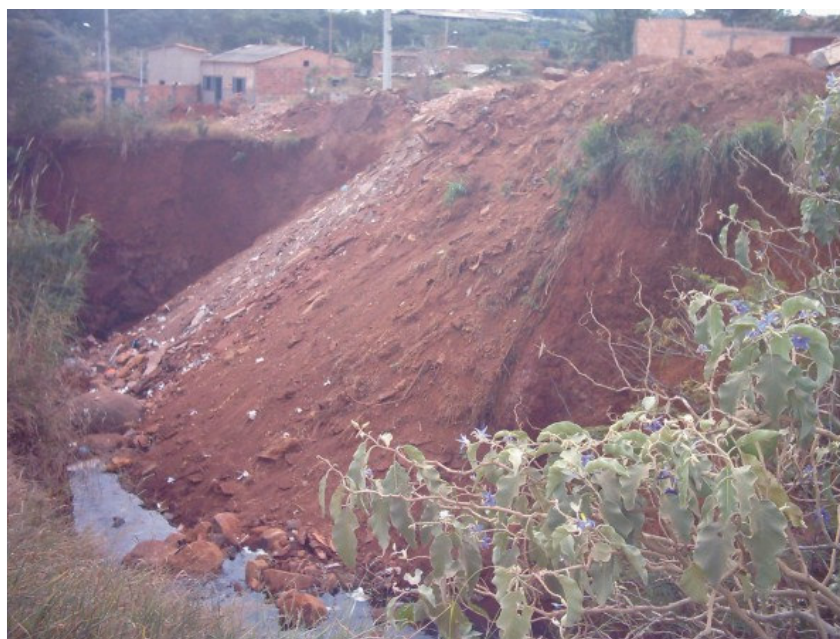
FIGURA 4 – Baixo curso do córrego Buritizinho. Detalhe para o desmoronamento da vertente em local onde foram depositados resíduos de construção civil para contenção da erosão.
