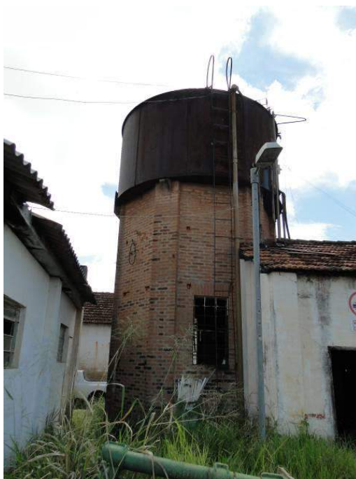
Figura 32 - Caixa d'água Conjunto Arquitetônico e Paisagístico da Estrada de Ferro Goiás/EFG em ferro que é sustentada pelos pilares e alvenarias e tijolos maciços
