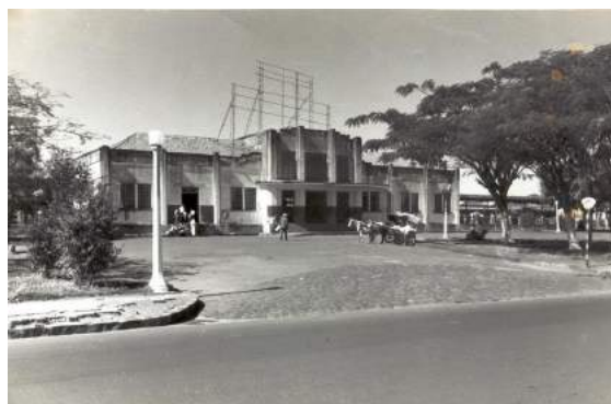
Figura 110 - Estação de Uberlândia - 4º exemplar. Observa-se a platibanda arrematando as fachadas da estação
