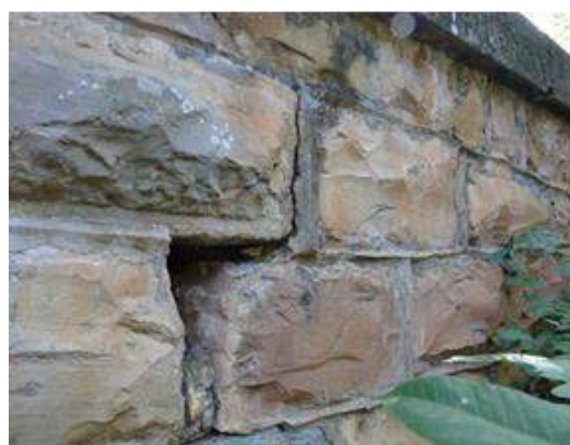
Figura 62 - Detalhe do embasamento de pedra que sustenta a ponte metálica
