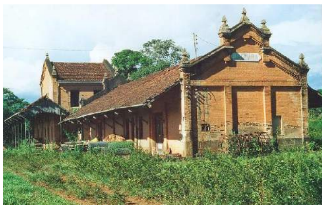
Figura 107 - Estação da Jagura – Nota-se a plataforma da estação independente ao telhado principal do prédio em duas águas. No armazém ao lado da estação a cobertura da plataforma é a continuação da água principal do telhado sendo sustentada por mãos-francesas em madeira.
