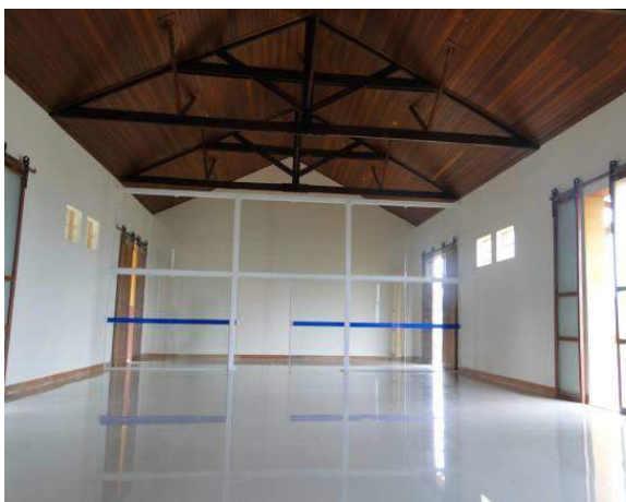
Figura 139 - Estação da Stevenson após o restauro. Observa-se o interior da estação com o piso em porcelanato, a divisória em vidro temperado onde será o espaço de memórias do prédio. Nota-se o forro de madeira que foi inserido no restauro mantendo as tesouras aparentes. Autor: CARILI, Clayton França. Fonte: Acervo Particular Data: 28 de dezembro de 2012.
