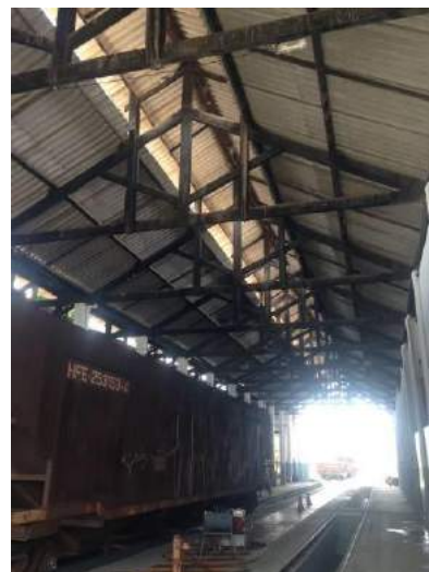
Figura 16 - Oficina de manutenção de Ibiá/MG. Observa-se o interior da oficina com a presença de lanternim para iluminação e as tesouras em madeira na cobertura.
