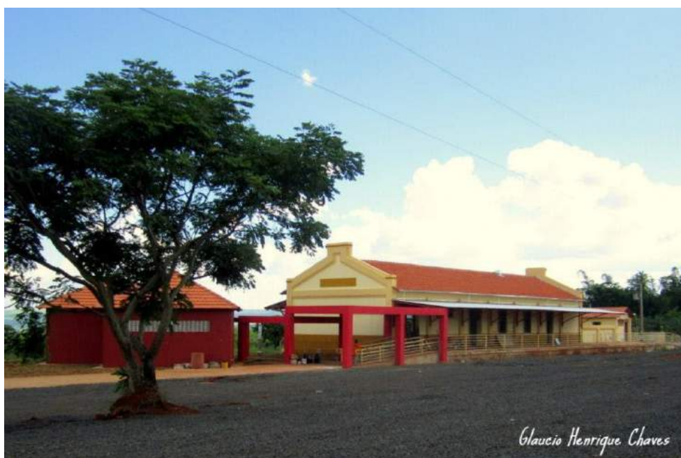
Figura 145 - Estação da Stevenson após o restauro. Vista do anexo construído ao lado da estação. Podemos notar que o anexo utiliza telhado aparente com telhas de barro francesas e está muito próximo à estação.
