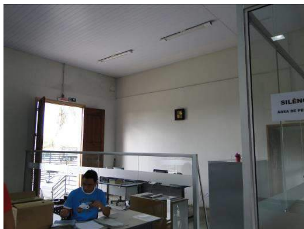
Figura 132 - Interior da antiga estação observa-se o forro de PVC que foi inserido durante o processo de restauro do bem cultural. Autor: CARILI, Clayton França. Fonte: Acervo Particular Data: 18 de janeiro de 2014.
