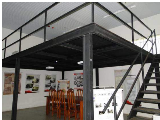
Figura 135 - A Estação de Uberaba após o restauro. Vista parcial de uma das salas. Observa-se o mezanino que foi criado em estrutura metálica Autor: CARILI, Clayton França. Fonte: Acervo Particular Data: 18 de janeiro de 2014.
