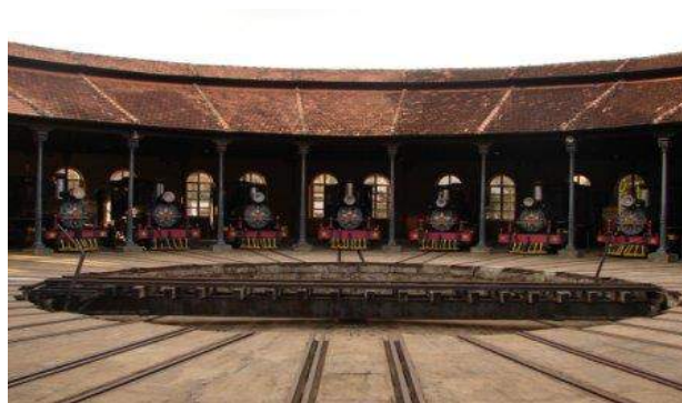
Figura 12 - Rotunda de São João Del Rey. Observa-se o interior da rotunda com o girador ao centro e os trilhos onde eram estacionadas as locomotivas para manutenção.
