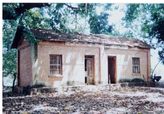
Figura 23 - Conjunto Arquitetônico da Estação da Jaguará. Nota-se a alvenaria de tijolos maciços sem reboco, as esquadrias em madeira e o telhado em duas águas, com telhas francesas.
