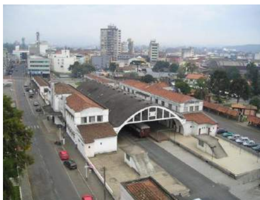
Figura 43 - Estação Central de Porto União da Vitória – Observa-se a estação bilateral divididas em dois volumes
