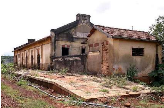
Figura 136 - Estações da Stevenson observa-se o péssimo estado de conservação e a ausência da cobertura da plataforma antes do restauro. Em primeiro plano a Casa de Turma, ao lado estação. Fonte: Acervo Digital da Fundação Aragarina de Educação e Cultura – Divisão de Patrimônio Histórico – Laudos técnicos sobre o estado de conservação de bens culturais tombados pelo município Autor: Sem informações Data: 16 de março de 2005
