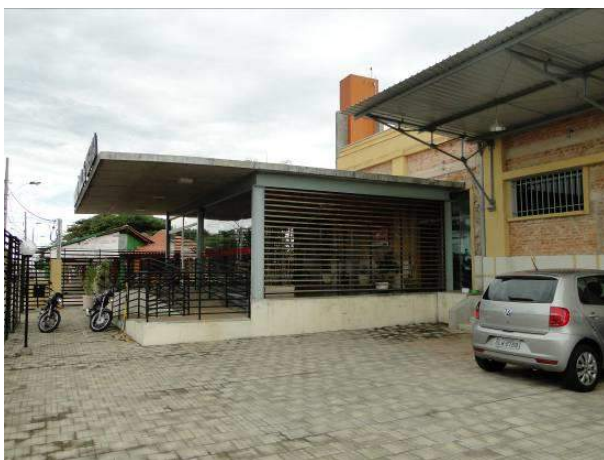
Figura 131 - A Estação de Uberaba após o restauro. Observa-se o foyer de acesso ao prédio que foi criado junto com a rampa e escada que são cobertas. A estrutura que sustenta a laje de concreto é metálica. Nota-se parte da alvenaria exposta com a retirada do reboco Autor: CARILI, Clayton França. Fonte: Acervo Particular Data: 18 de janeiro de 2014.
