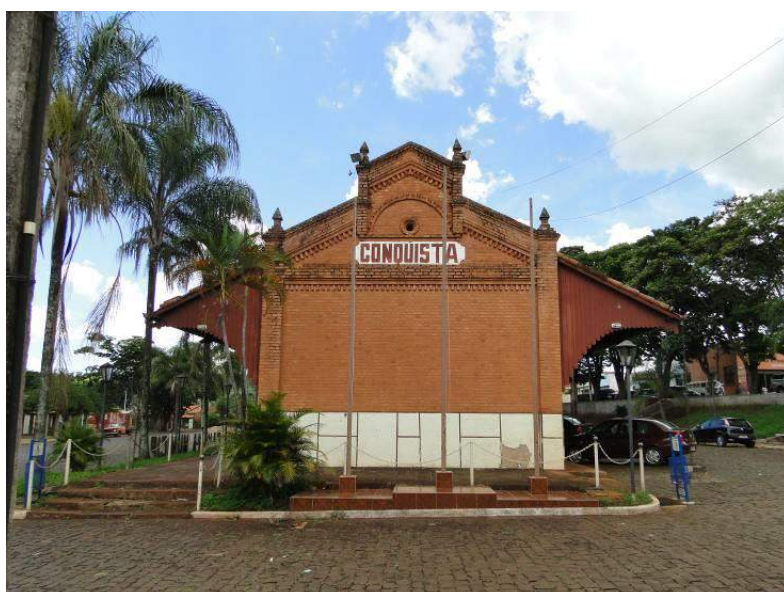
Figura 123 - Estação de Conquista observa-se na fachada menor com fechamento das mãos-francesas com madeira e o barrado que foi rebocado posteriormente durante as obras de adequação e manutenção do prédio.
