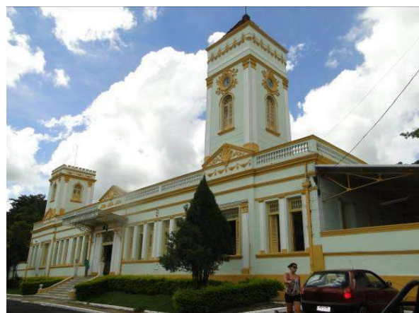
Figura 112 - Estação de Araxá – Observa-se a platibanda em toda extensão da cobertura com a presença de balaustrada, frontões triangulares com desenhos e as duas torres que marcam o edifício.
