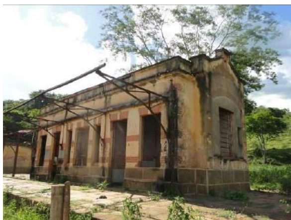
Figura 111 - Estação do Cipó – Observa-se a platibanda em toda extensão da cobertura com cimalha e o frontão.
