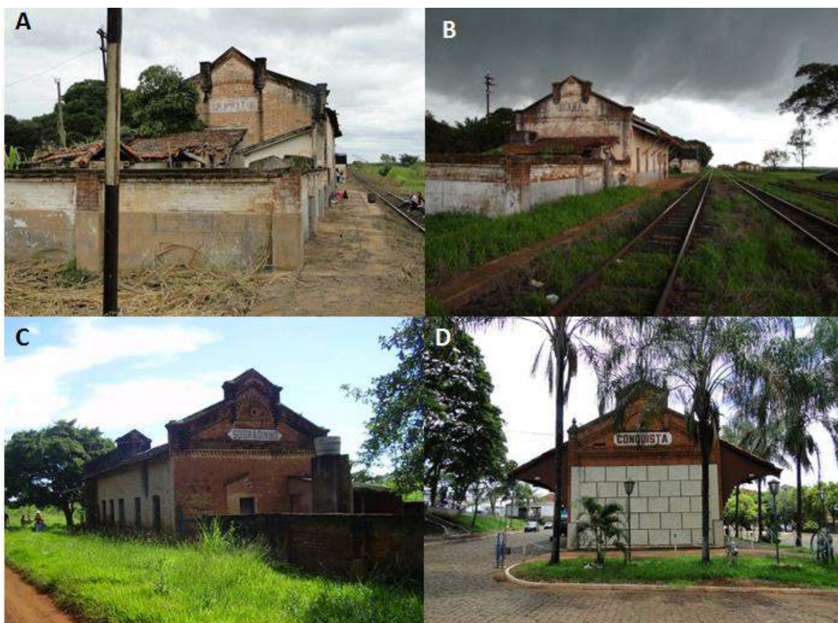
Figura 104 - Estações com frontão com as alvenarias de tijolos a vista formando as cimalhas e arremates com a presença ou não de pináculos.
