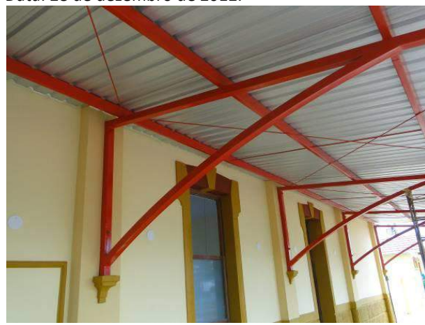
Figura 144 - Estação da Stevenson após o restauro. Observam-se as mão-francesas metálicas que foram inseridas com desenho simplificado, pois não havia referências da antiga sendo pintadas em vermelho para destacar que é um elemento novo e a cobertura com telhas termo acústicas.
