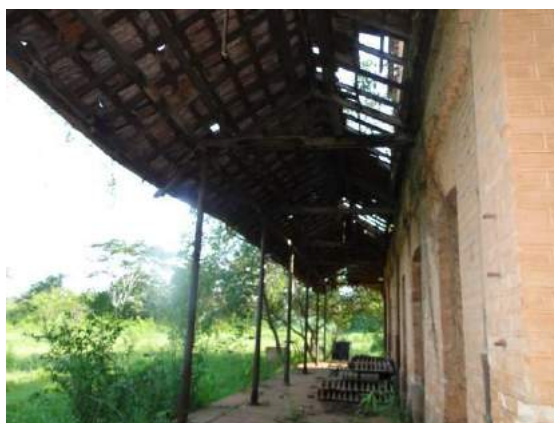
Figura 108 - Estação da Jaguara – Nota-se a plataforma em duas águas, independente ao telhado principal da estação, sendo a estrutura em madeira com telha de barro tipo francesa e os pilares que a sustentam em ferro.
