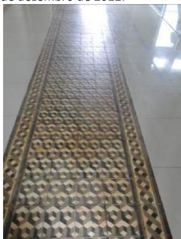
Figura 143 - Estação da Stevenson após o restauro. Observa-se o piso em ladrilho hidráulico que foi confeccionado sendo o mesmo desenho do ladrilho encontrado na estação. Podemos notar o porcelanato bege.
