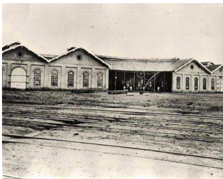
Figura 14 - Rotunda de Uberaba. Observa-se o exterior da rotunda semicircular. O edifício foi construído pela Companhia Mogiana de Estrada de Ferro. Podemos notar as empenas triangulares a presença dos óculos.
