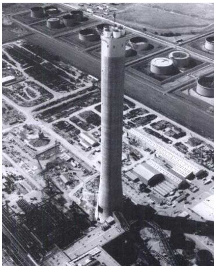
Figura 6 - Chaminé da usina de Isle of Grain, Kent, Inglaterra.
